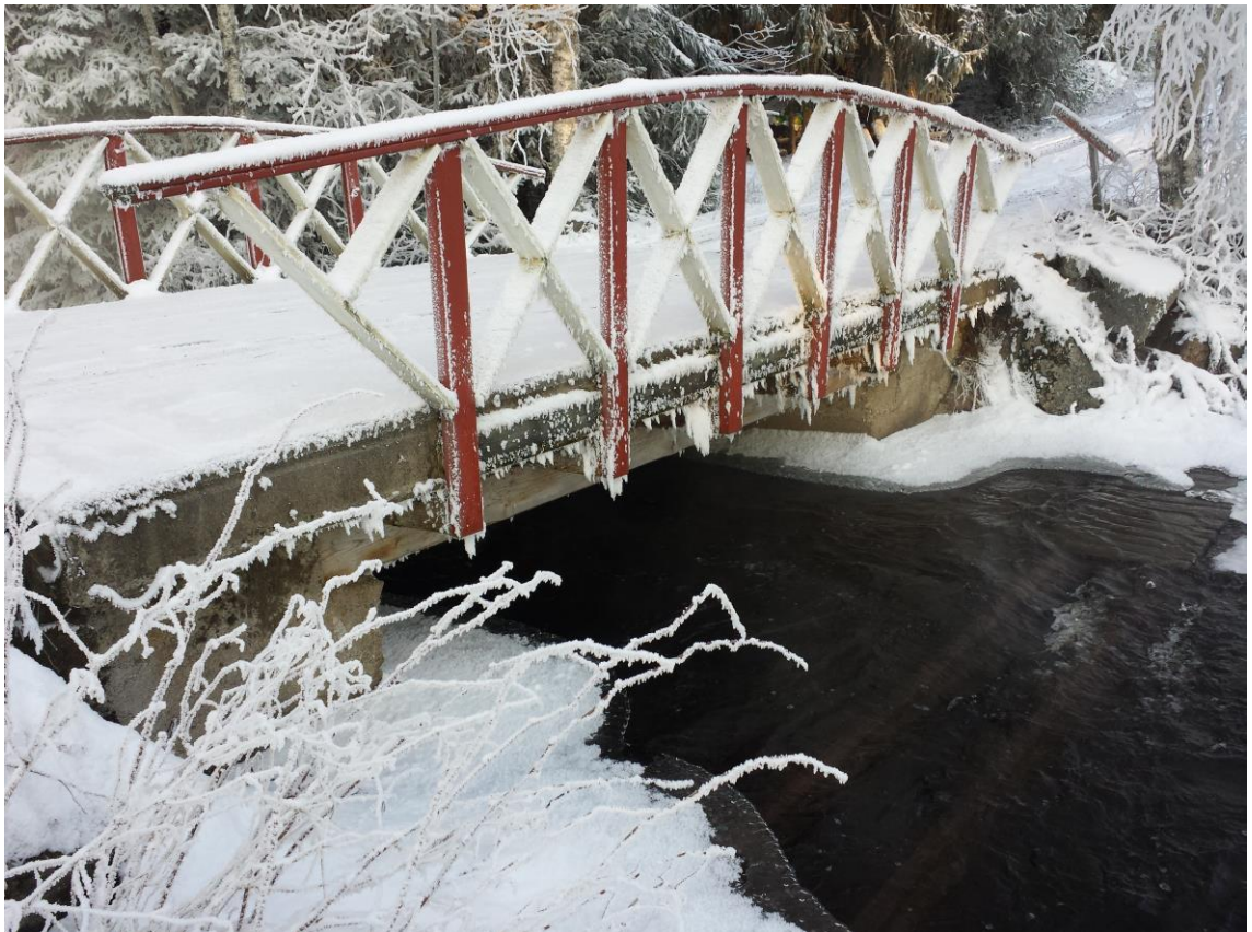
KUVA 1. Vanhan sillan yleiskuva
