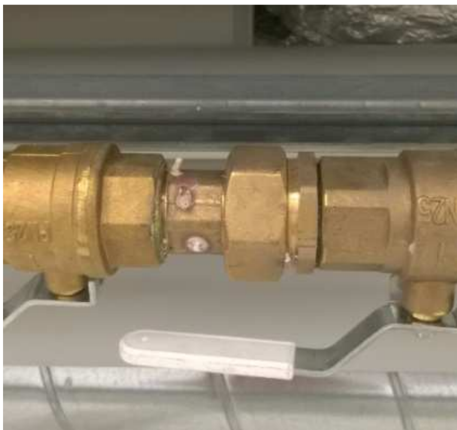
Kuva 4: Kuva sinkinkadosta
