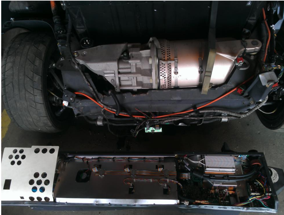
Kuva 2. Vaurioitunut sähköyksikkö alhaalla, jossa näkyy vääntynyt suojakotelo. Ylhäällä sähkömoottori ja vaihteisto.
