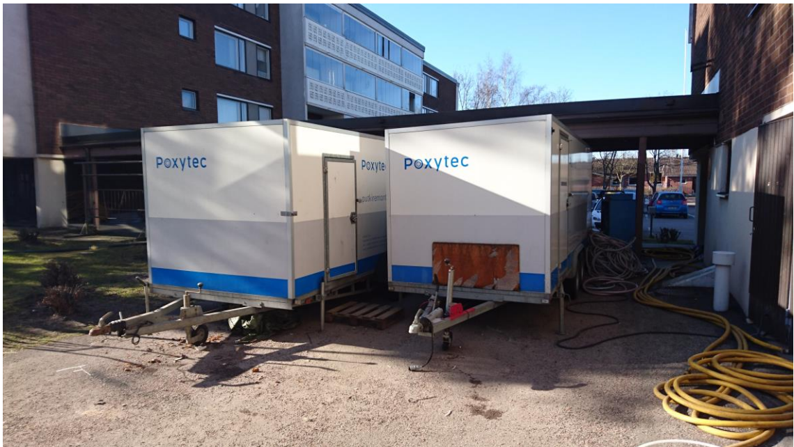
Kuva 4. Työmaakontit sijoitettuna työmaalle
