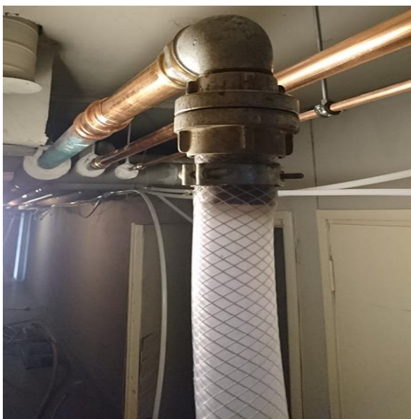
Kuva 13. Alipaineimurin liitännä saneerattavan linjan loppupäässä
