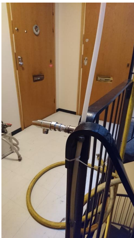
Kuva 18. Väliaikainen vesipiste ja laskuhana sijoitettuna porraskäytävään
