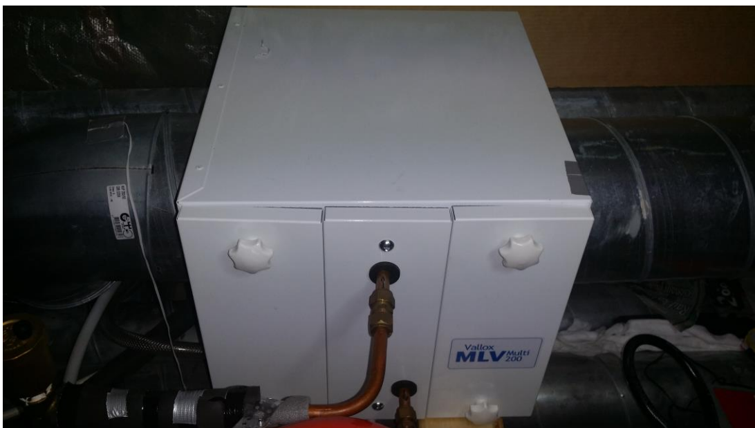
Kuva 3. Lämmityspatteri asennettuna ulkoilmaa tuovan kanavan väliin.
