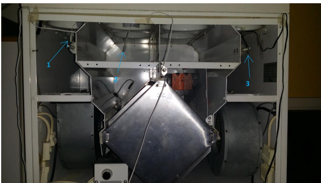
Kuva 14. Nuolilla merkatut mittauspisteet ilmanvaihtokoneessa.
