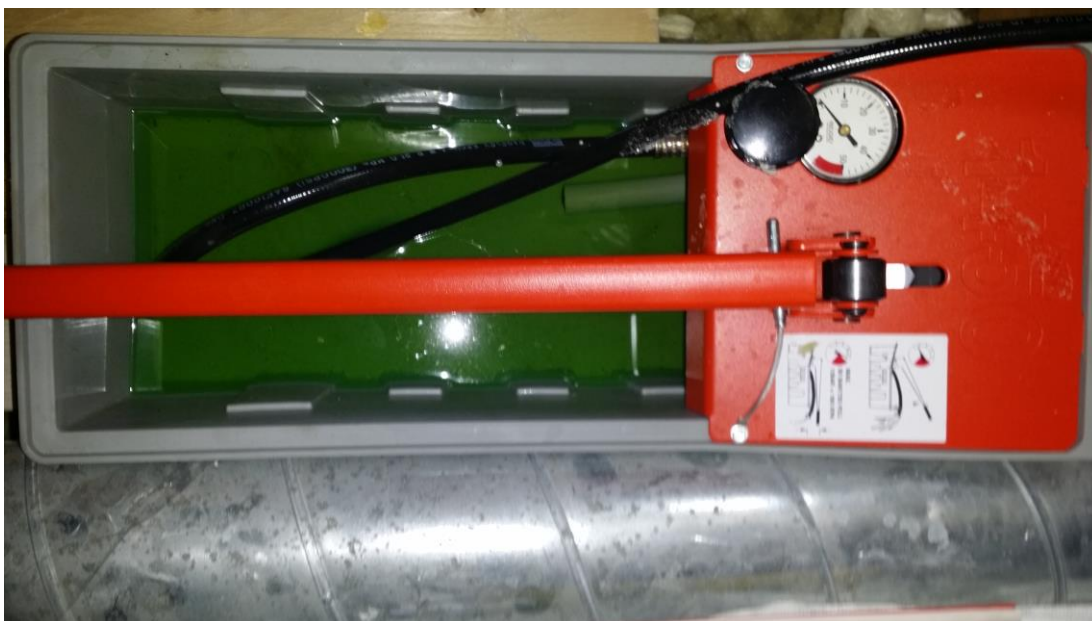
Kuva 6. Ridgid koepainepumppu auttoi järjestelmän tiiveyden varmistamisen ja esipaineen asentamisen.
