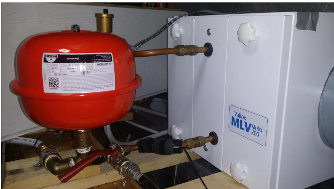
Kuva 5. Zilmet merkinen kalvopaisunta-astia torjuu mahdolliset paineen muutokset.
