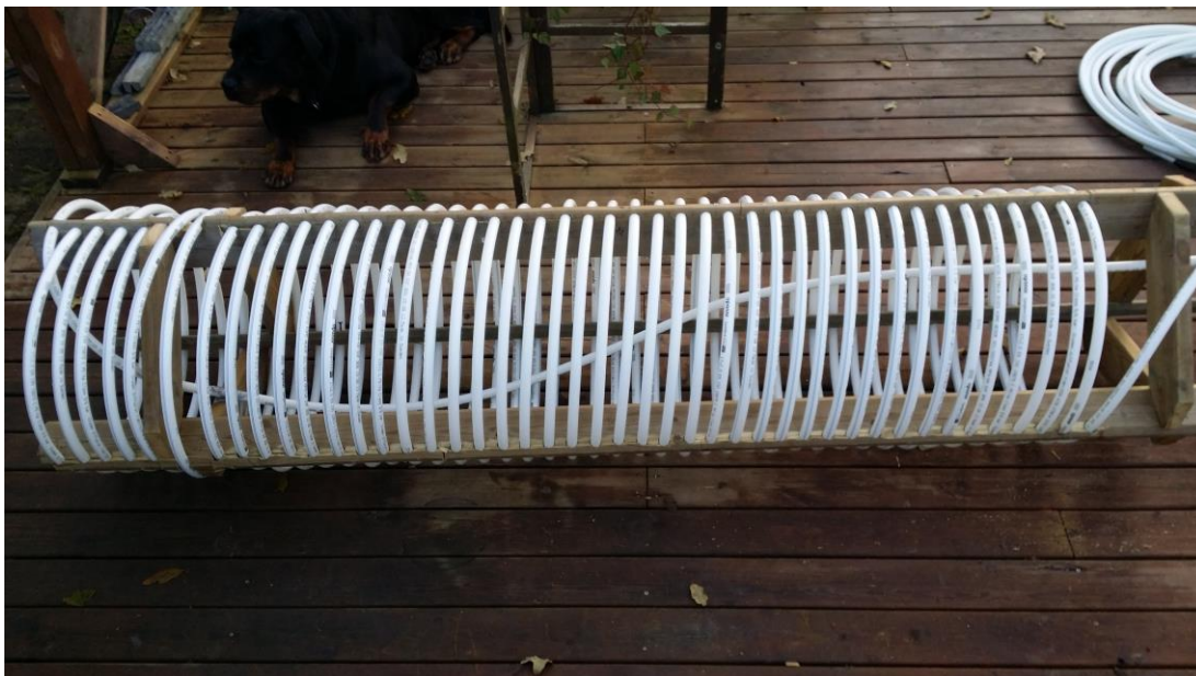
Kuva 2. Putki kierretty telineeseen valmiiksi kaivoon asentamista varten.
