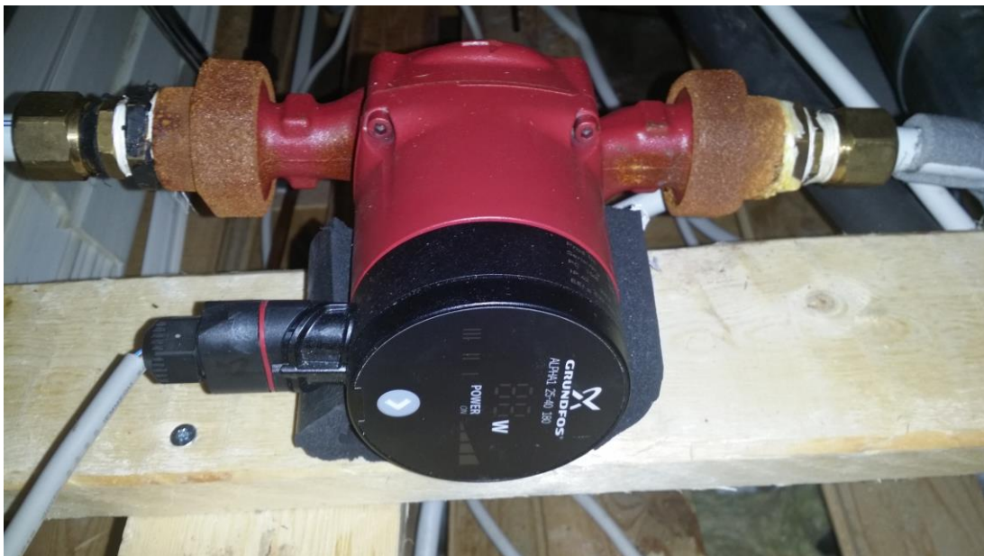
Kuva 4. Grundfos merkinen energiatehokas kiertovesipumppu
