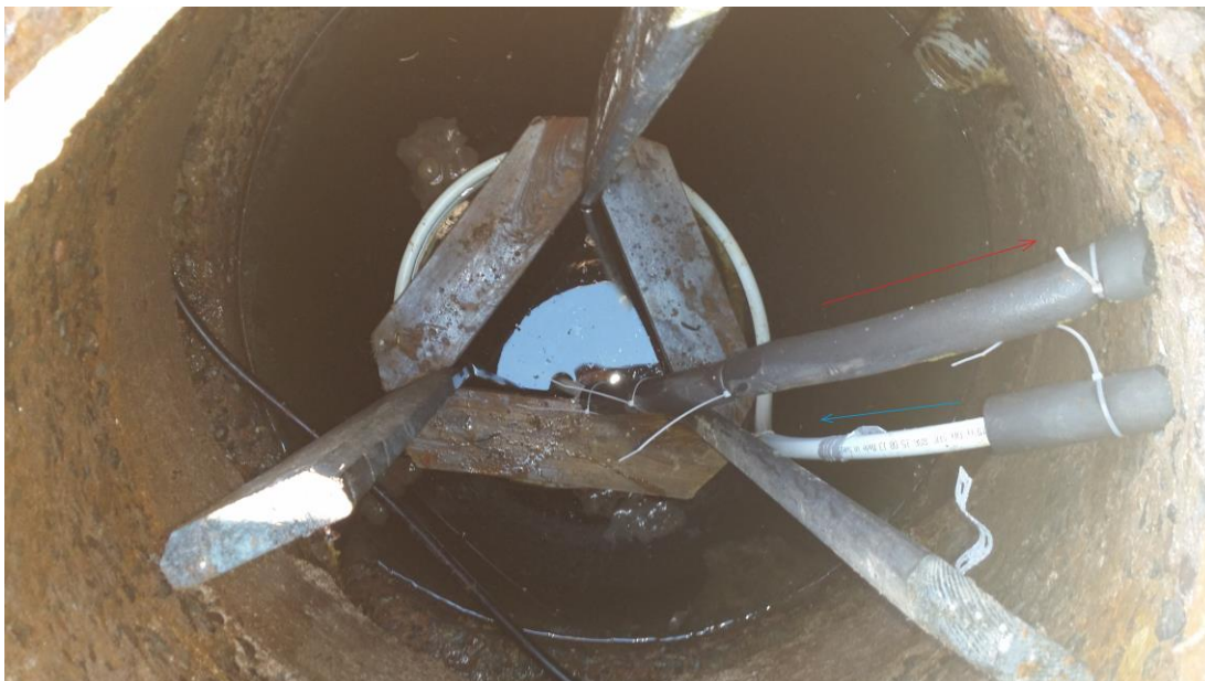
Kuva 7. Keruuputkisto asennettiin betoniseen sadevesikaivoon.
