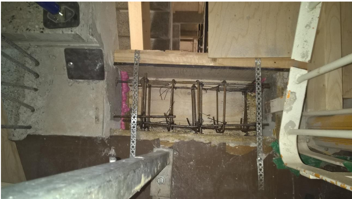
KUVA 9. Aukon raudoitus ja muotti
