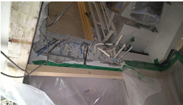
KUVA 13.. Katkenneet sähköjohdot
