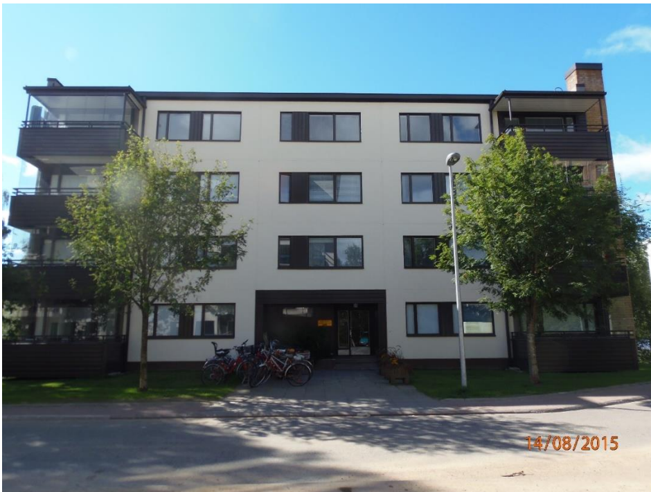
KUVA 2. Asunto Oy Veitikantie 28
