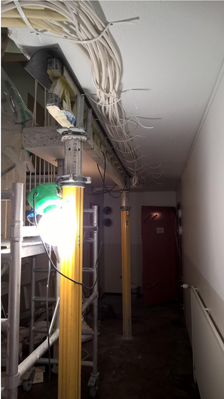
KUVA 14. Korjatut sähköjohdot
