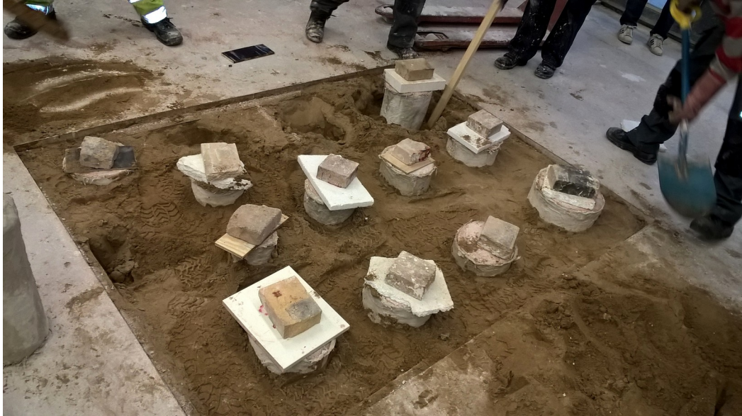
Kuva 5 Muotteja kaivetaan hiekkaan.
