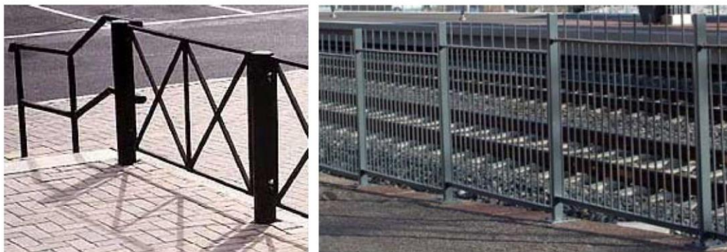
KUVA 9. Vasemmalla kaupunkiympäristöön tarkoitettu aitatyyppi B ja oikealla Pitäjänmäen aseman erikoissuunniteltu teräsaita (tyyppi C) (Ratahallintokeskus 2004)
