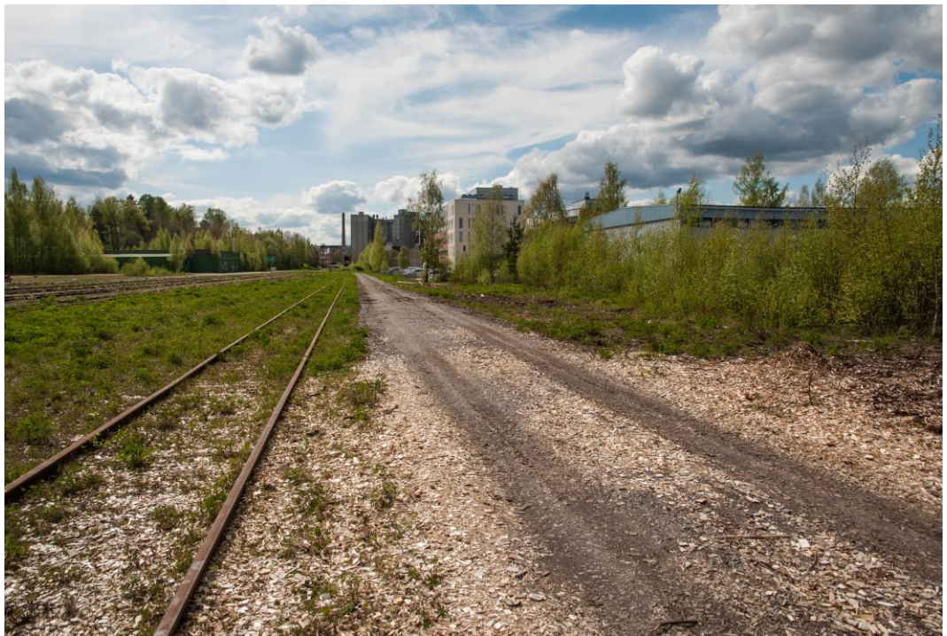
Mukkulan ratapihaa koillisesta, ratapihan pohjoisreunalta katsottuna
