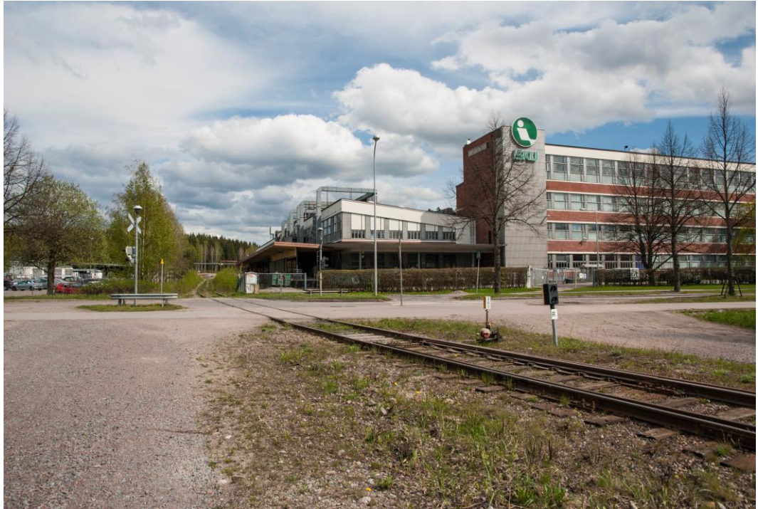
Rautatiealueen ja Mukkulankadun risteys. Taustalla Iskun tehdaskiinteistö.
