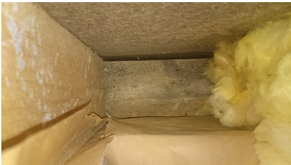
KUVA 5. Valesokkelin kantavan seinärungon alaohjauspuu (23.2.2016 Haapakorpi)
