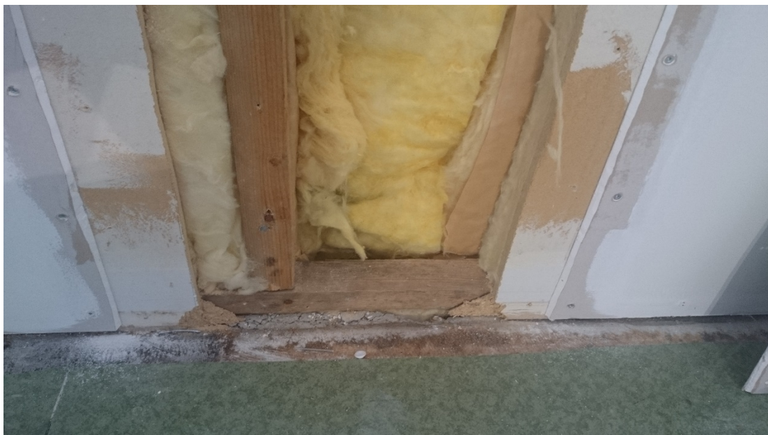
KUVA 4. Avattu seinärakenne (23.2.2016 Haapakorpi)
