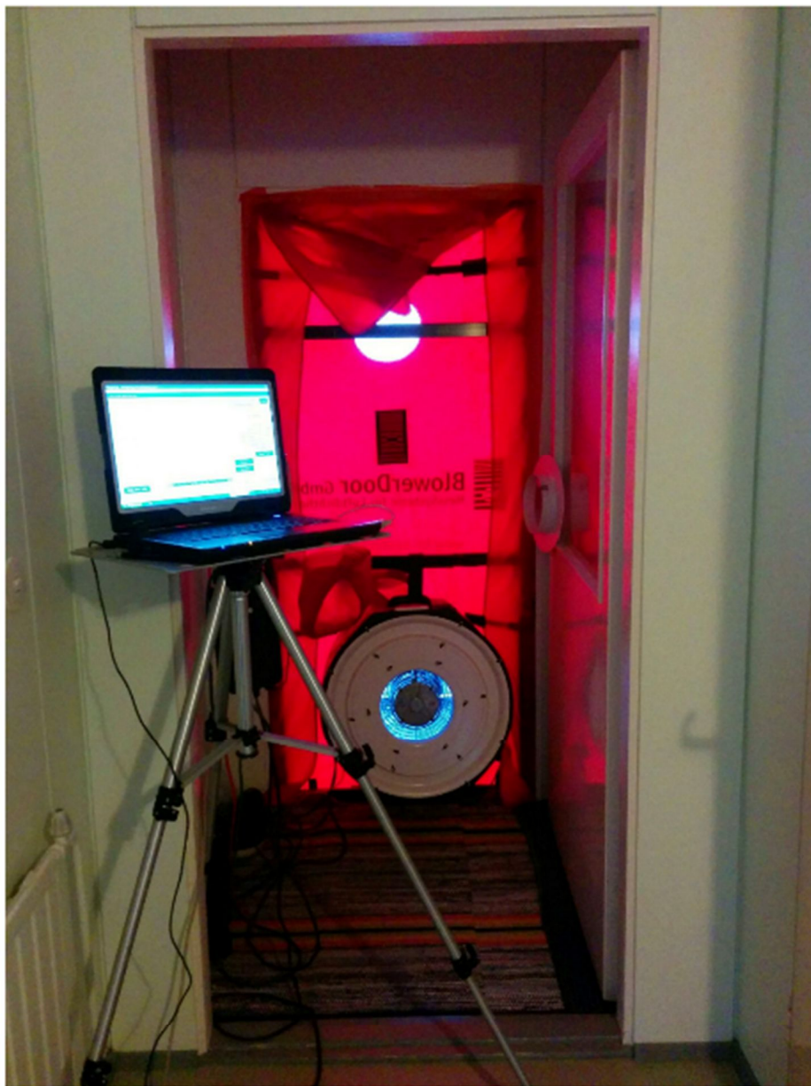
Kuva 1. Paineovälitteistä asennettuna pääsisäänkäynnin ovioukkoon.
