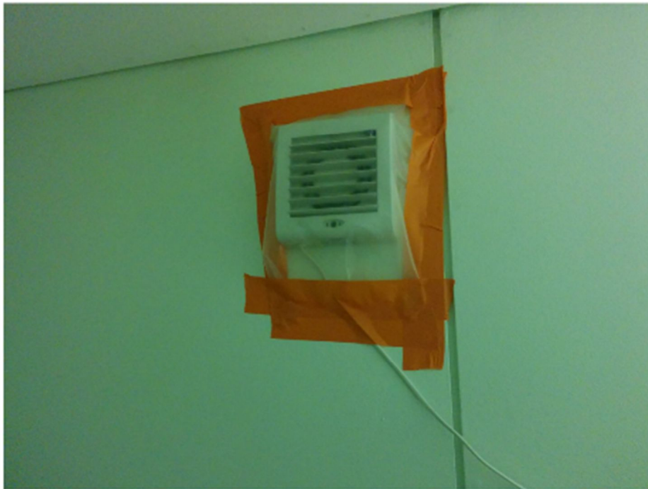
Kuva 3. Vessan poistokanava tulkittu.
