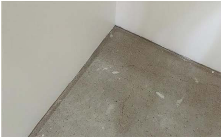
Kuva 2. Laboratorion lattia ennen käsittelyä
