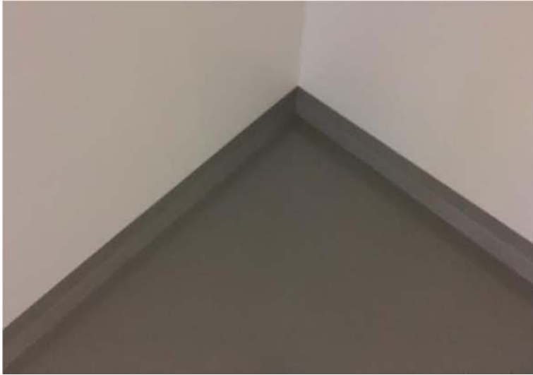
Kuva 4. Laboratorion valmis lattia
