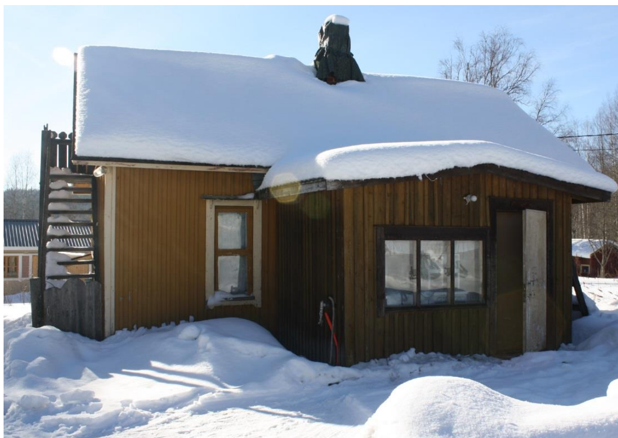
Kuva 3. Vanhan rakennuksen julkisivu kuvattuna helmikuussa (Pasanen 2016)
