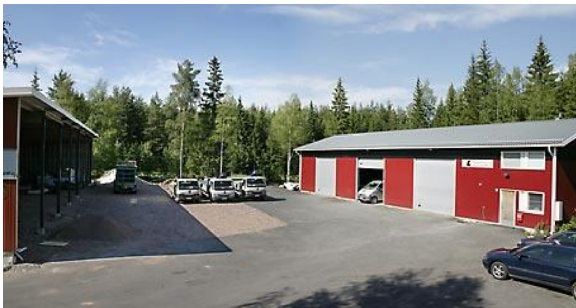
Kuva 2. Rakennustyöt Ville Kauppi Oy:n toimipiste Kauttualla.
