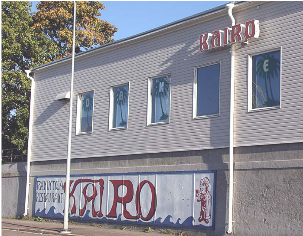
KUVA 1. Kairon julkisivu satamaan päin
