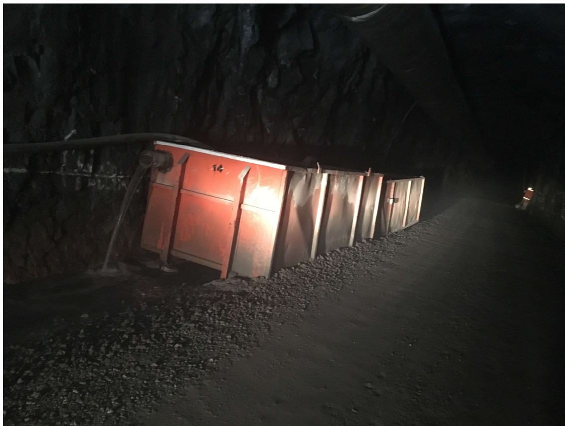
Kuva 18 Mikkilänkallion työmaan yksi poistoveden keräysaltaista.
