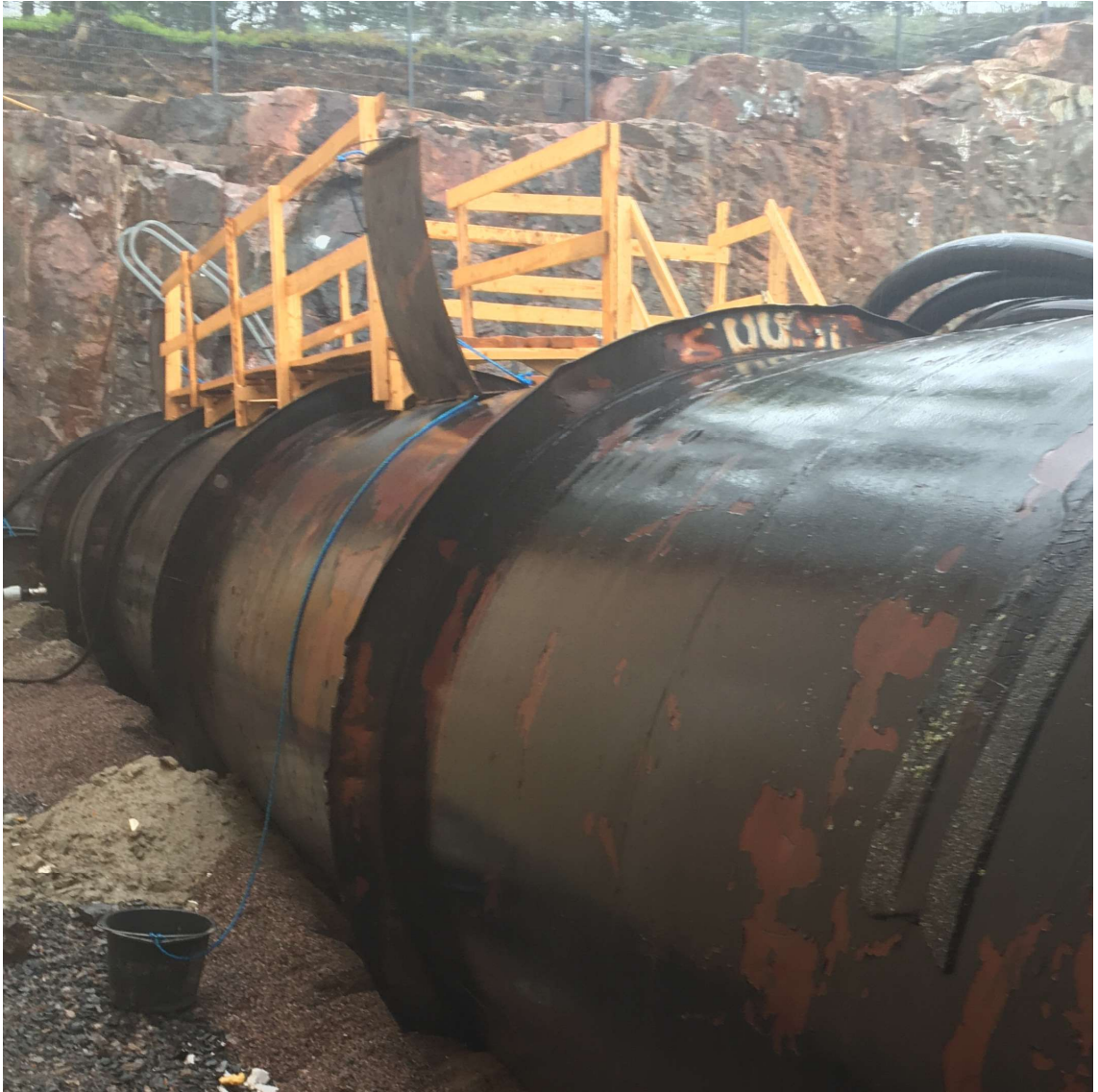
Kuva 26 Sadan kuution allas, jonka loppupäästä vesi pumpataan takaisin tunnelin kierrätysvesipisteisiin.
