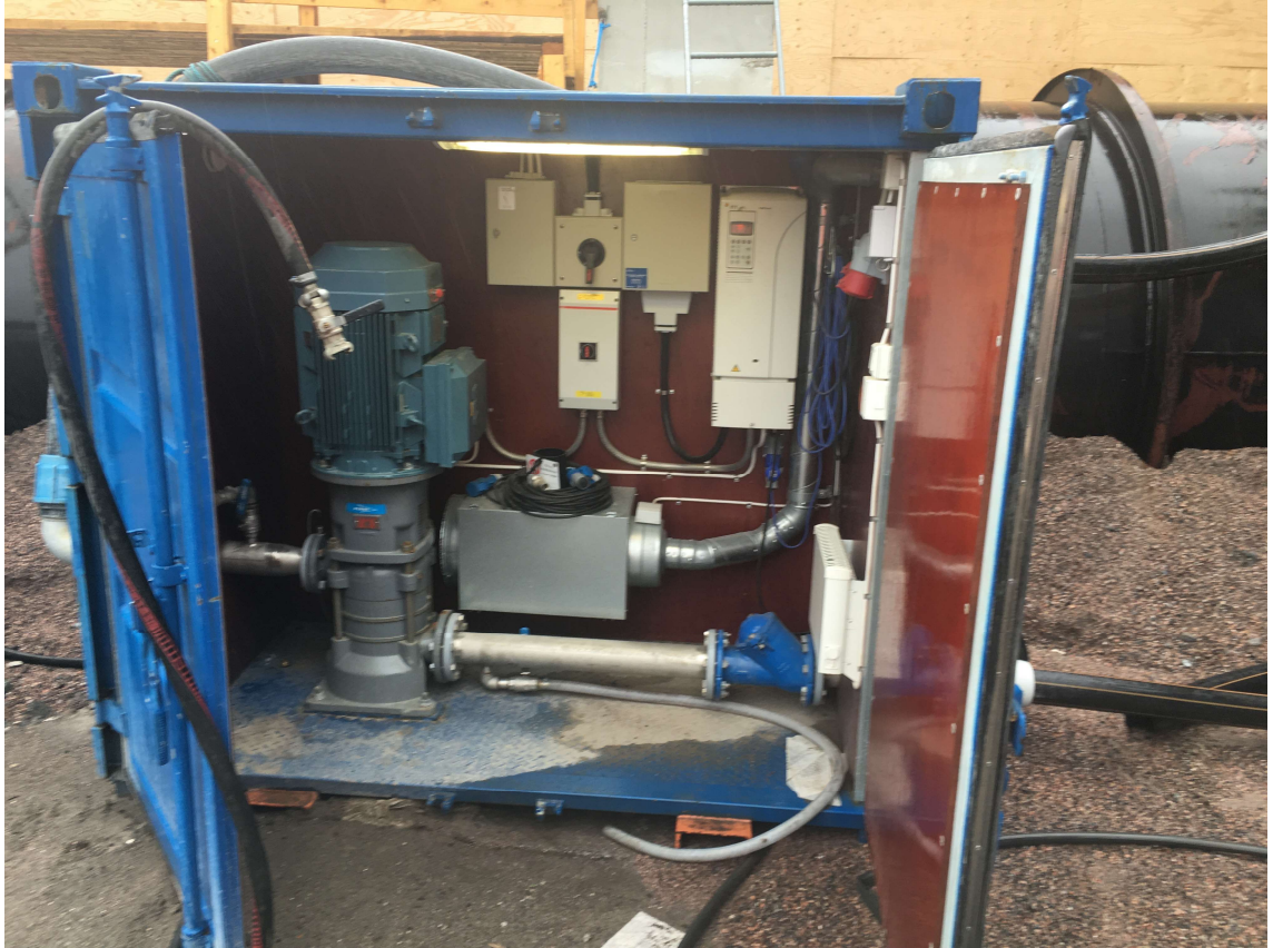
Kuva 27 Pumppujärjestelmä, jonka avulla kierrätysvesi pumpataan takaisin tunneliin käytettäväksi.
