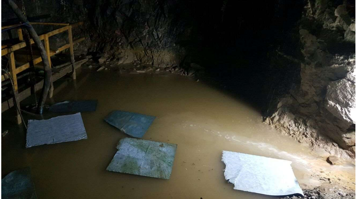
Kuva 21 Tunnelin sisään louhittu selkeytysallas.
