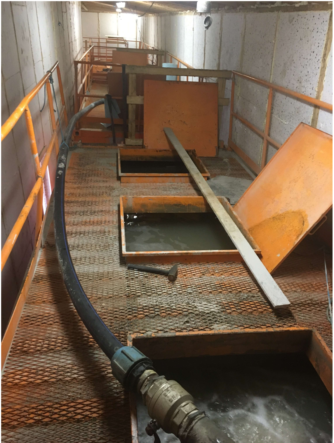
Kuva 22 Tunnelin suuaukon läheisyydessä sijaitsevat jälkiselkeytysaltaat.
