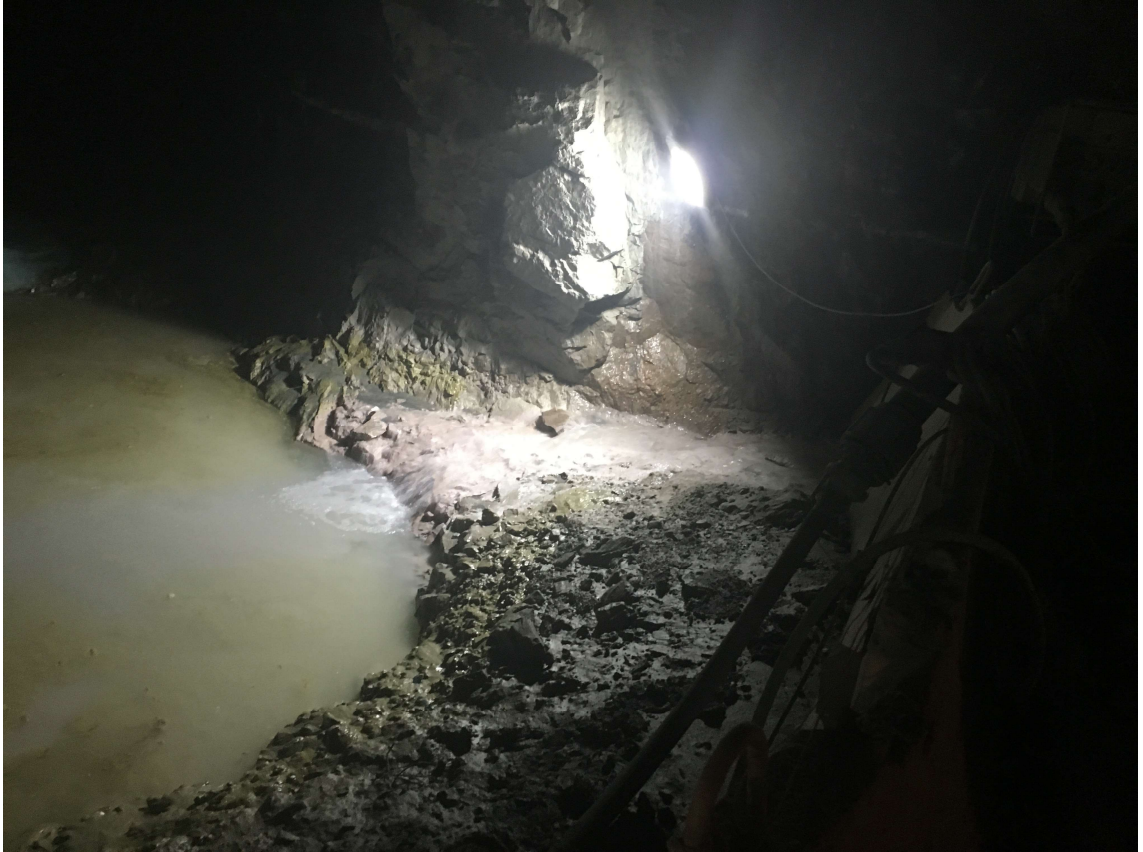
Kuva 20 Poistoveden päätyminen ojasta selkeytysaltaaseen.
