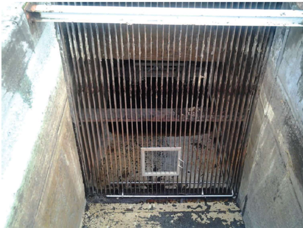
Kuva 4 Jätevedenkäsittelylaitoksen välppä (Puru 2015, 10).
