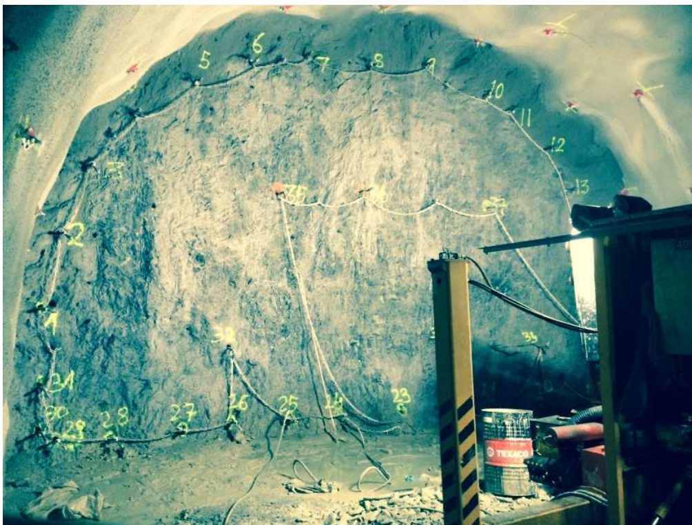
Kuva 14 Esimerkkikuva Norjan Stavangerin E39 Eiganesmaantietunnelista, jossa näkyy juuri ruiskubetonoitu tunnelin pinta ja käynnissä oleva perään injektointityöt
