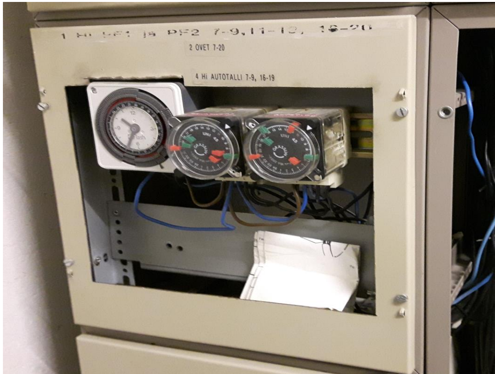
Kuva 2. Puutteellinen kosketussuojaus.
