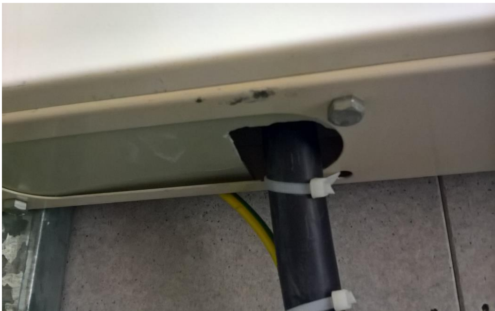
Kuva 7. Syöttökaapelin kiinnitys ja läpivienti.
