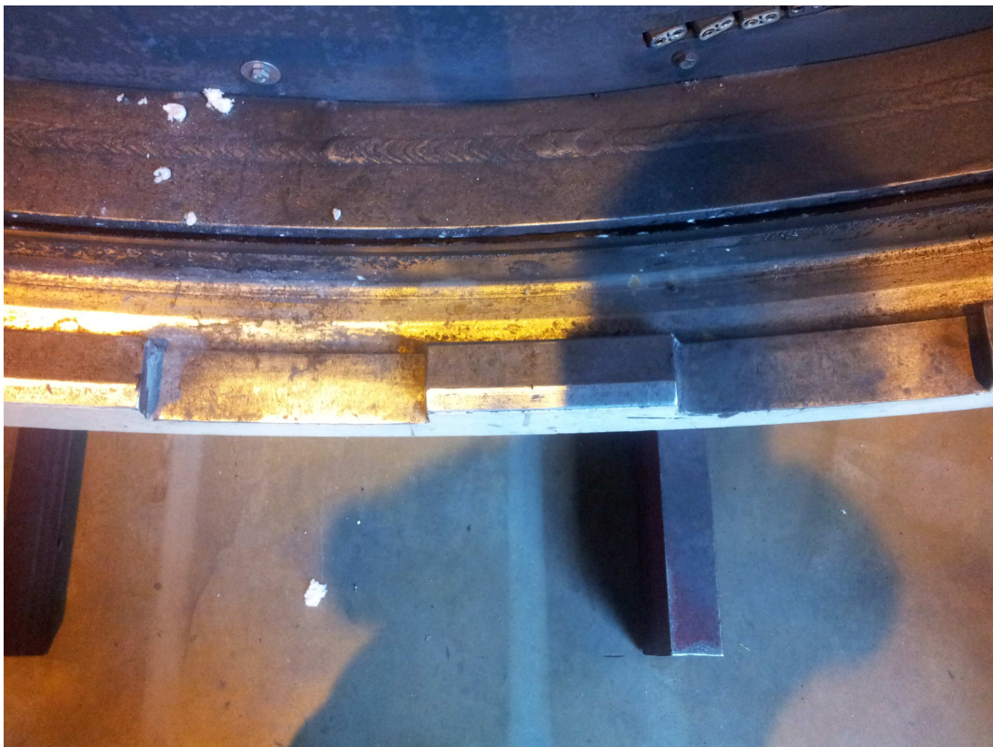
Kuva 6. Luukun vastakappaleen hammastus ja tiivisteiden ura. (Alm 2015)
