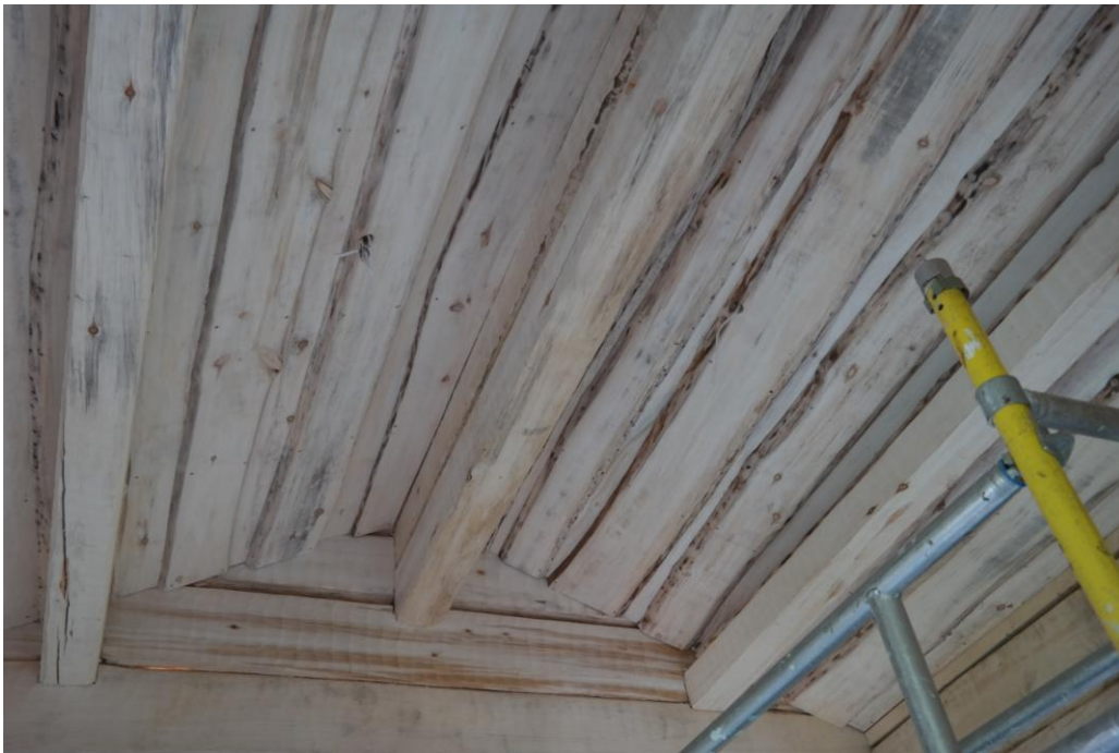
Kuva 20: Tuppeensahattu haapalauta
