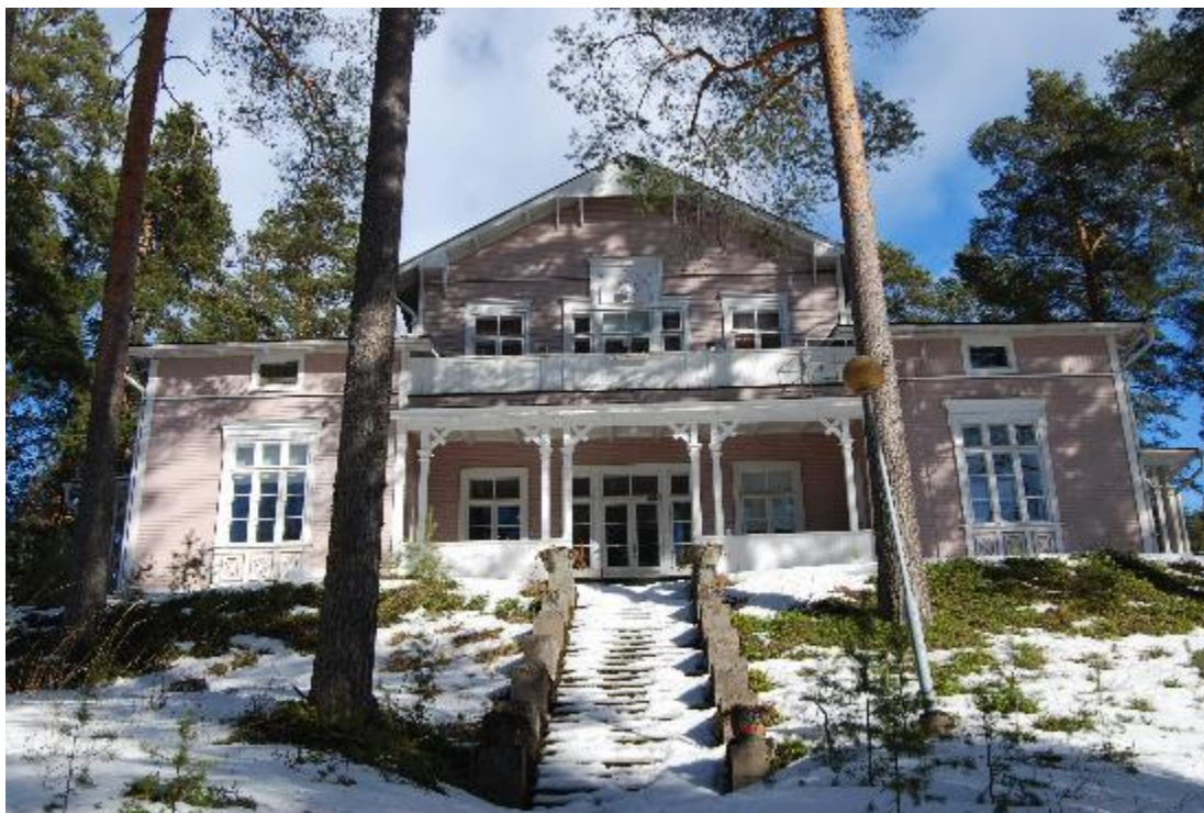
Kuva 15. Keisarinnan kunniaksi rakennettu huvila vuodelta 1898. (Utti 2016.)
