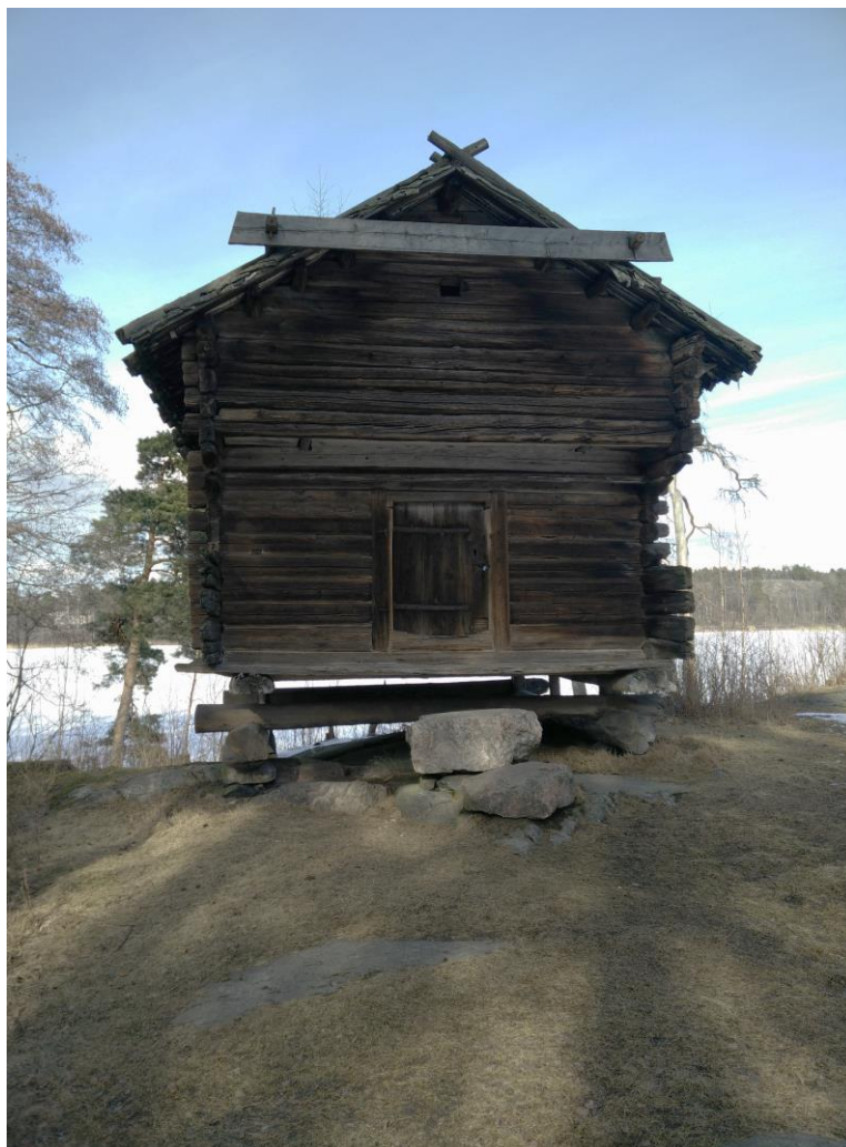
Kuva 1. Lamasalvostekniikalla rakennettu hirsitalo Helsingin Seurasaarella. (Utti 2016.)
