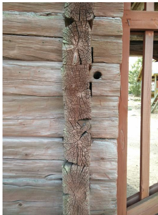
Kuvat 2 ja 3. Kaksi erilaista nurkkaliitosta Helsingin Seurasaaren ulkomuseossa. (Utti 2016.)
