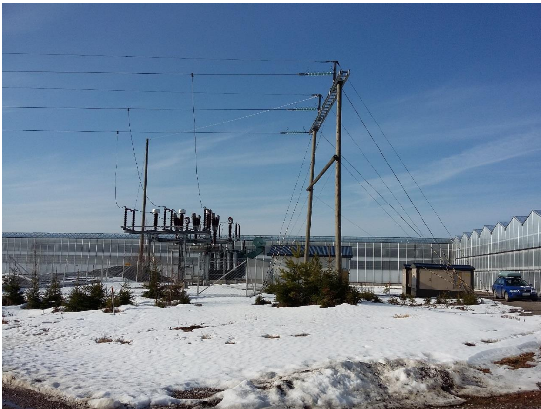
KUVA 11. Partaharjun Puutarhan 110kV liittymispiste sekä puistomuuntamot A ja F (Huusko 2016.)
