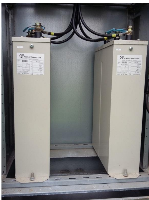
KUVA 13. Kondensaattoriparistot (Huusko 2016.)
