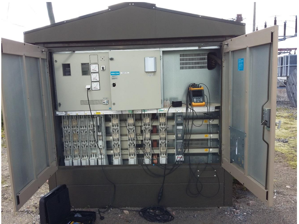
KUVA 14. Mittalaite muuntajalla A (Huusko 2016.)
