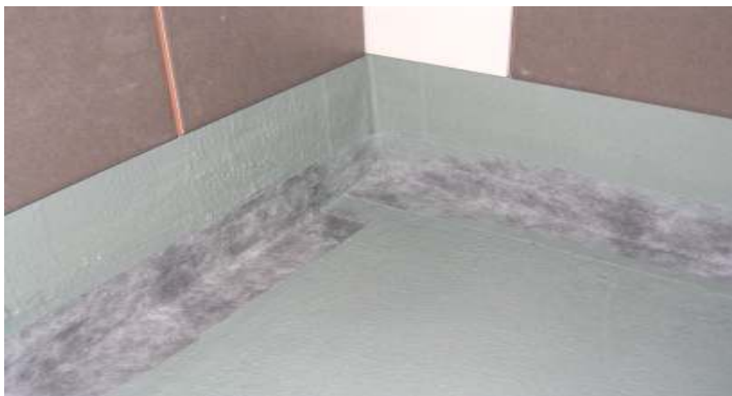
KUVIO2 Vesieristuksen nurkkavahvistenauha asennettuna
