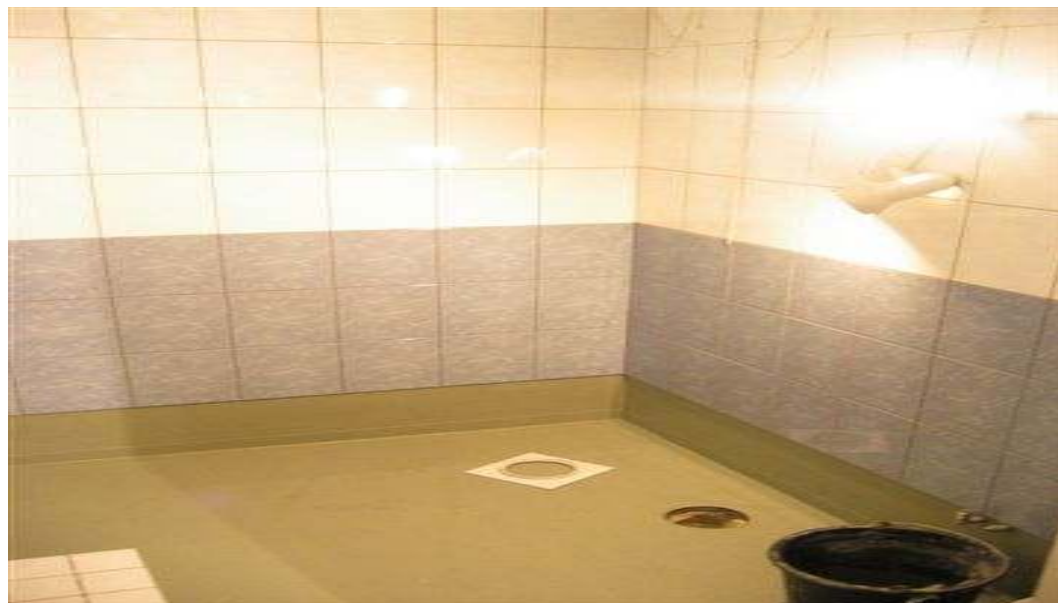
KUVIO4 Valmista seinälaatoitusta
