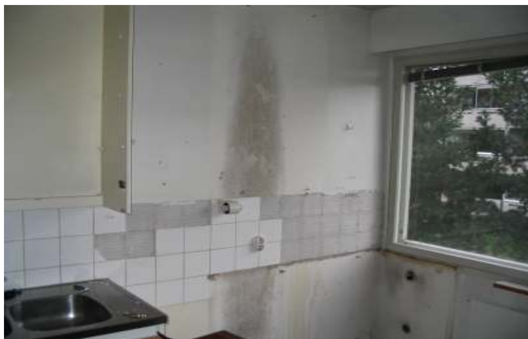
KUVIO1 Vanhojen kalusteiden takaa paljastuvaa seinäpintaa
