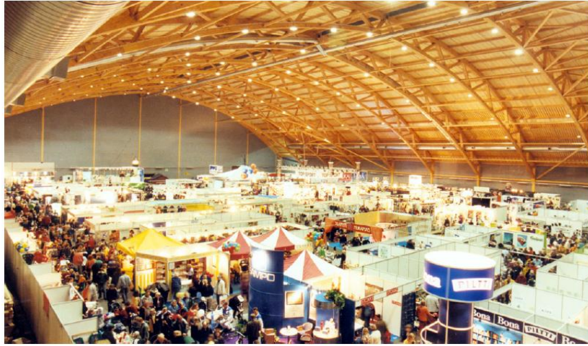
KUVIO 6. Pirkkahallin ristikkorakenteinen laajennusosa messukäytössä (Puuinfo Oy 2007.)
