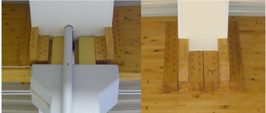
KUVIO 40. Pilari-palkkiliitos ja sekundääripalkin liitos primääripalkkiin
