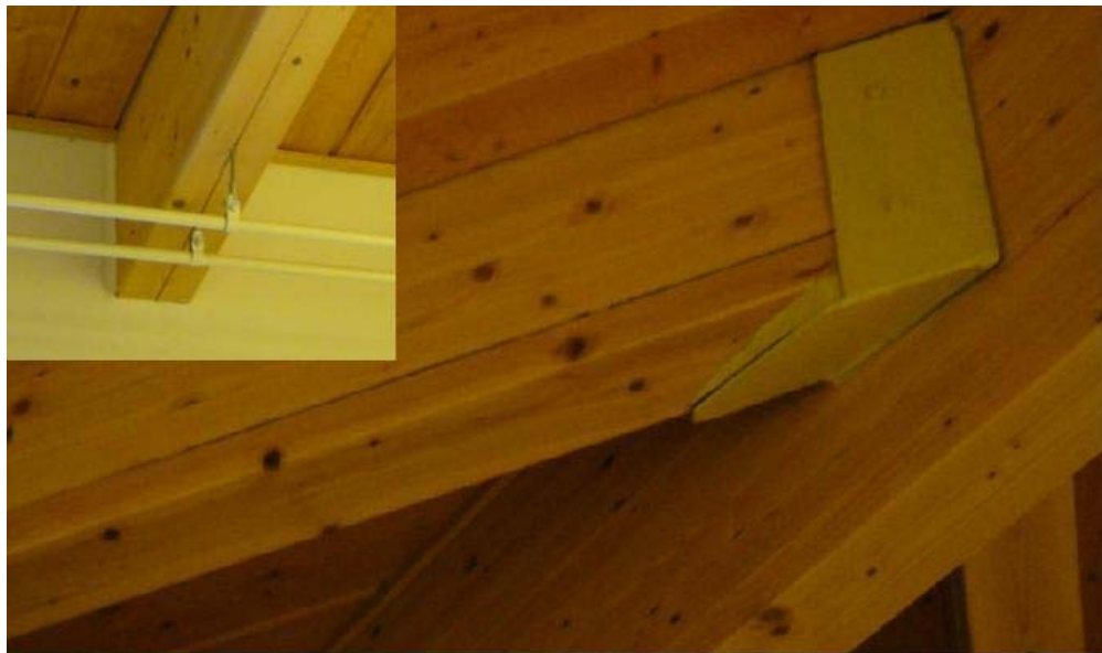
KUVIO 39. Ripustus – ja pulttiliitoksien aiheuttamat halkeamat
