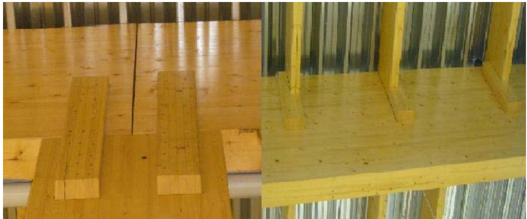
KUVIO 45. S-Market Ankkurin pilari-palkkiliitos ja sekundääripalkkien loveus pääpalkkiin
