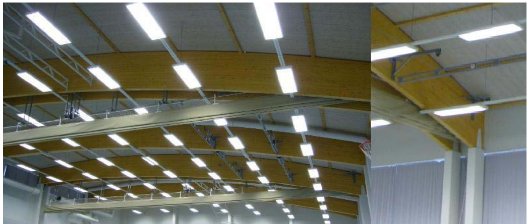
KUVIO 44. Olavin toimintakeskuksen kaaripalkit ja liitos
