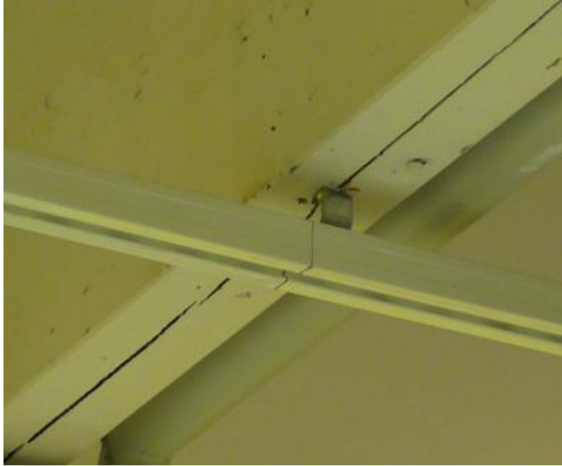
KUVIO 51. Halkeama palkin alapinnassa ripustuskuormakiinnityksen juuressa
