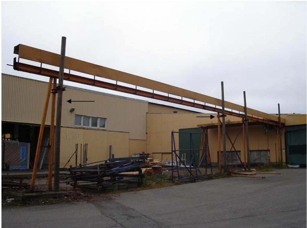
KUVIO 7. Kahden vasemmanpuoleisimman tukipalkin välistä pystytään tavaravirta toteuttamaan
