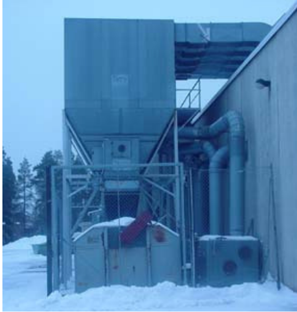
Kuva 2. Valumallin valmistuksen, puuosaston koneistussalin ja kokoonpanosalin purunpoistojärjestelmän puhaltimet, imetyn ilman ulospuhallusaukot ja suodatetun ilman takaisinkierätyskanavistot.
