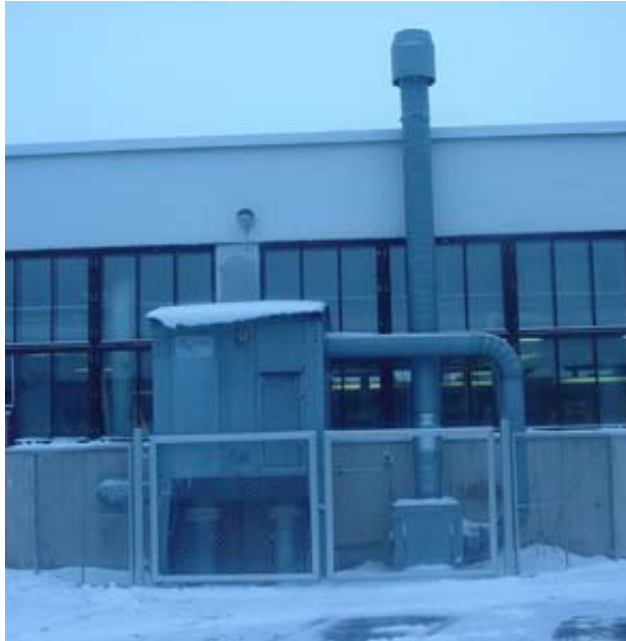
Kuva 3. Puuosaston kokoonpanosalin leveänauhahiomakoneen pölynpoistojärjestelmän suodatinyksikkö sekä puhallin.
