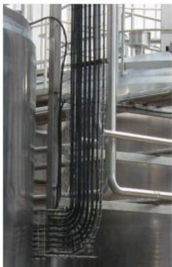
Kuva 15. Esimerkki hyllyn asentamisesta (EHEDG 2014: 119).
