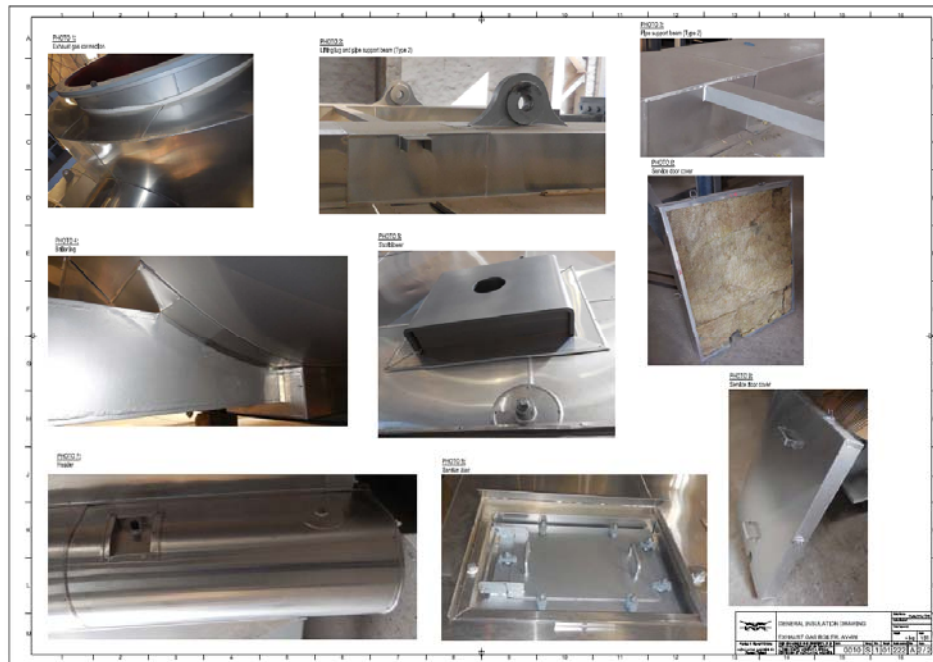
Kuva 29. Referenssivalokuvia kattilan eristyslevyjen asennuksista
