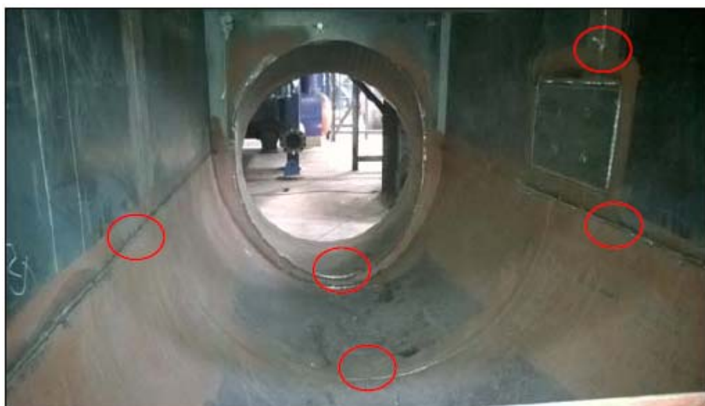
Kuva 20. Esimerkki AV-6N kattilan hitsaussaumojen tarkastusohjeesta
