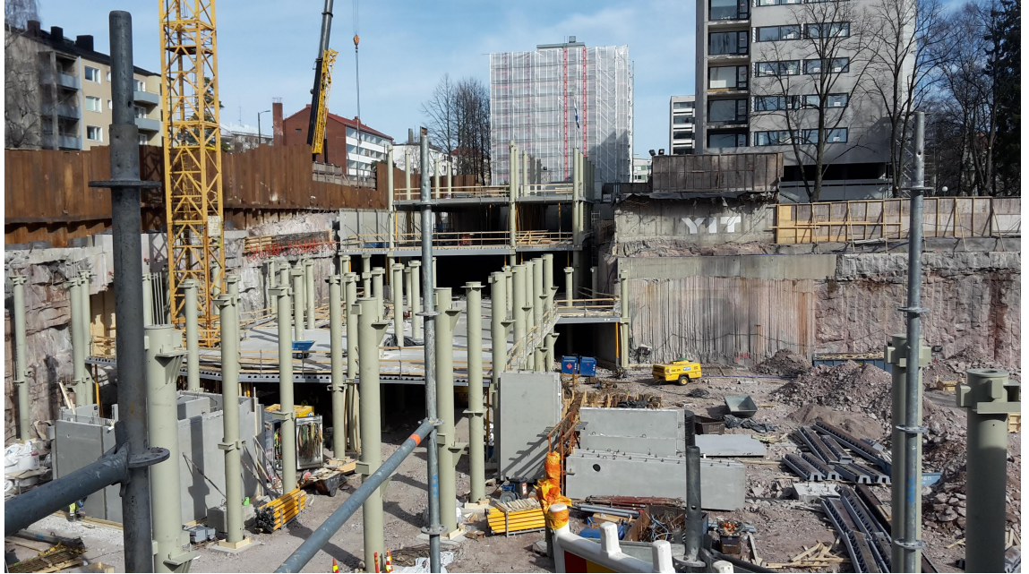
Kuva 5 Yhteinen työmaa: Infrapuolen ja toimitilapuolen samanaikaisesti käynnissä olevat työt [18].
