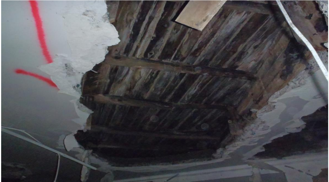
Kuva 12. Palkkivälistä on poistettu alalaatta ja raudoitukset katkaistu.
