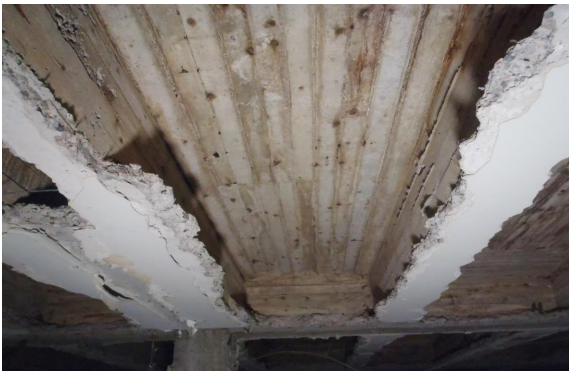
Kuva 13. Vanha muottilaudoitus on purettu ja pinnat puhdistettu
