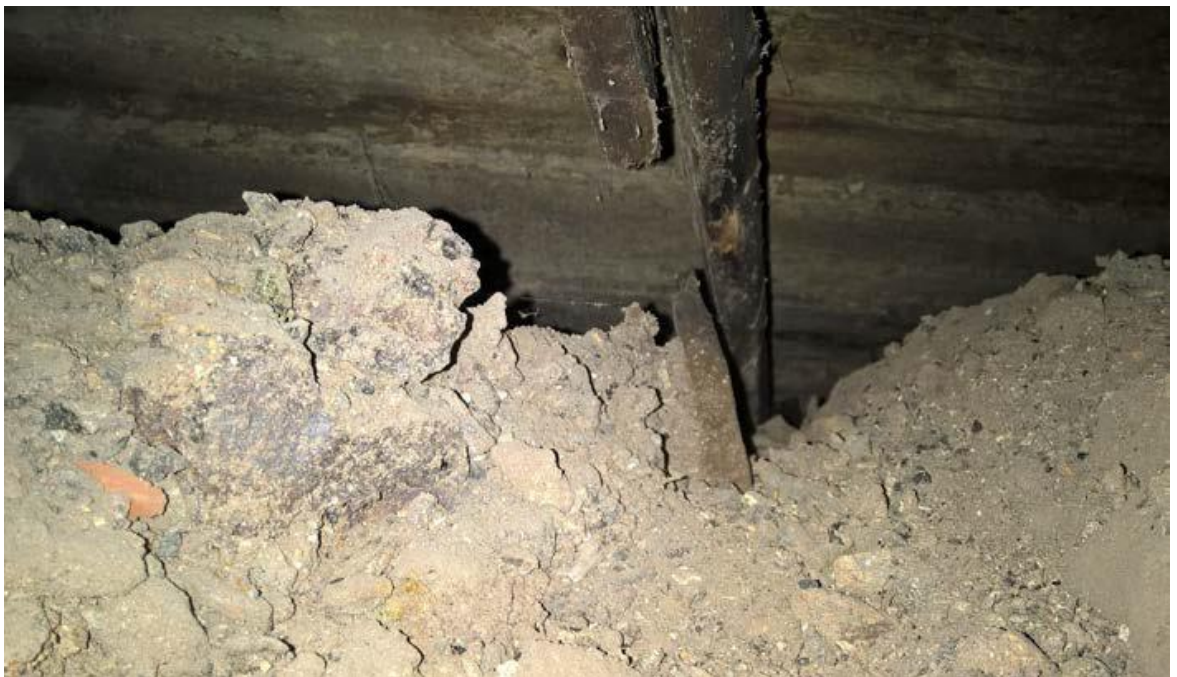
Kuva 9. 7.krs. välipohjan rakenneavaus
