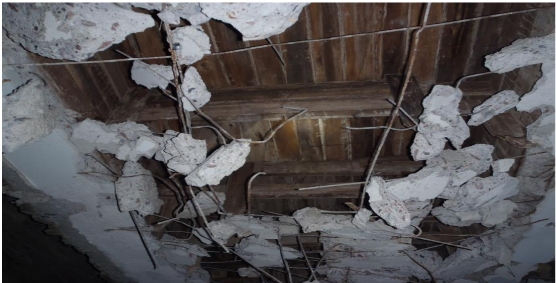
Kuva 11. Alalaatan poisto sekundääri palkkien välistä.
