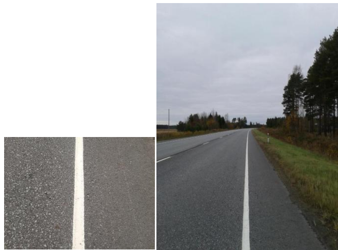
V2S1, K4(kuva pv. 17.10.-14), (Spray +1,2mm.13.9.-14)
