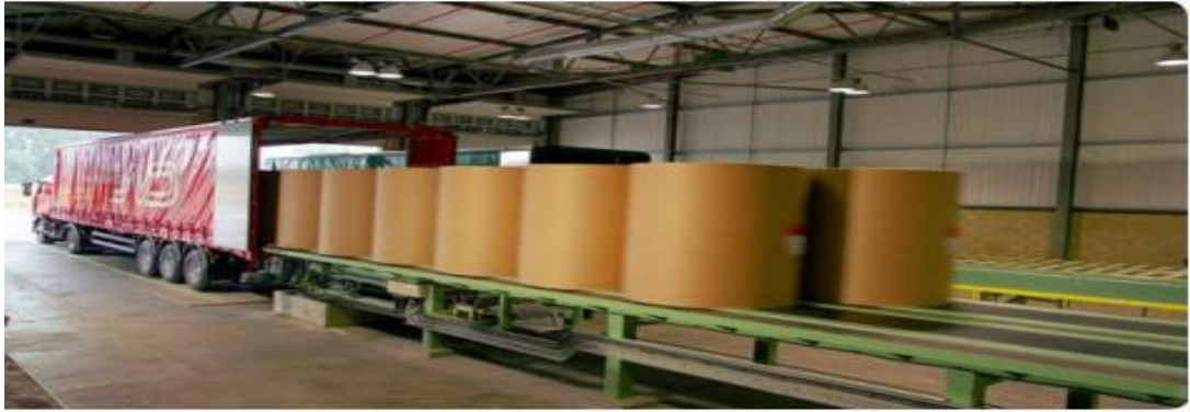
Kuva 19. Belt conveyor system (thinkloink-scs.com 2016)
