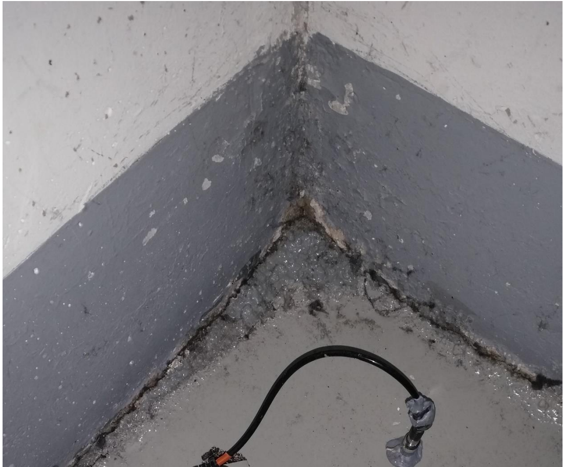
Kuvio 14. Kuva lattiarakenteen ja seinän liitoksesta hallin nurkassa (Jykes 2016.)
