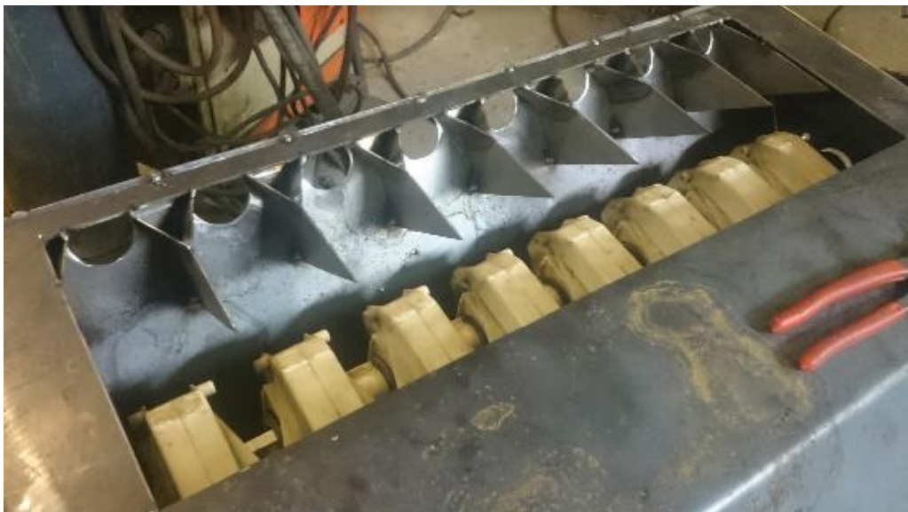
Kuva 15. Puhallinkotelon pohjakartiot asennettuna.
