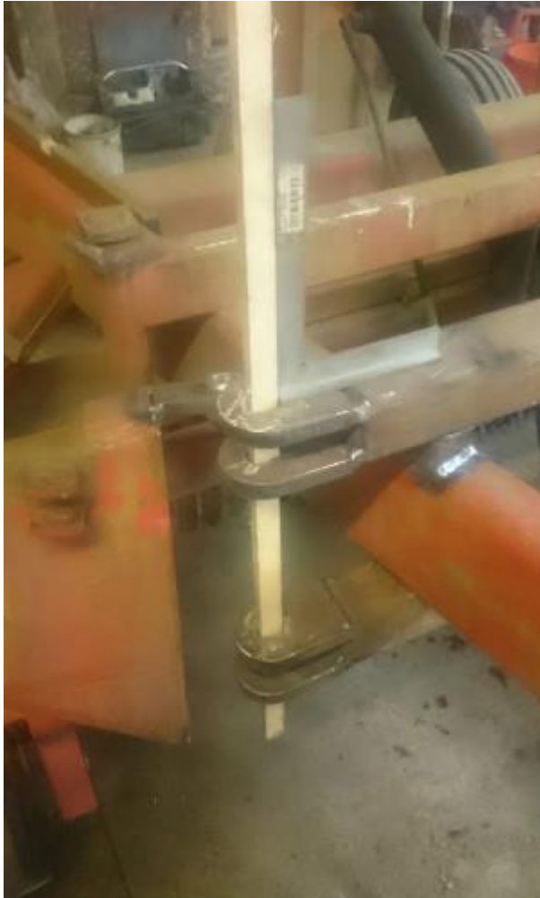
Kuva 19. Uusien saranoiden linjausta, taustalla näkyvät vanhat saranapisteet.
