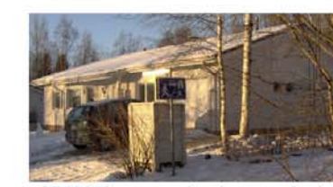
25. 90-luvun asuinrakennus, jonka julkisivumateriaali pääasiassa tiiltä
