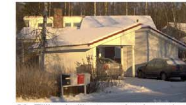
23. Tiiliverhoiltu asuinrakennuksesta näkyy kadulle oikeastaan vain katto
