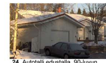
24. Autotalli edustalla, 90-luvun tiiliverhoiltu asuinrakennus taustalla
