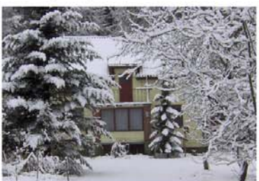
6b. Rapattu päärakenus, yksityiskohtia tiilistä
