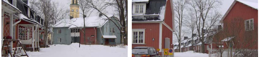
Kuvat 24 ja 25. Uudisrakennukset ovat osa pihapiiriä.
