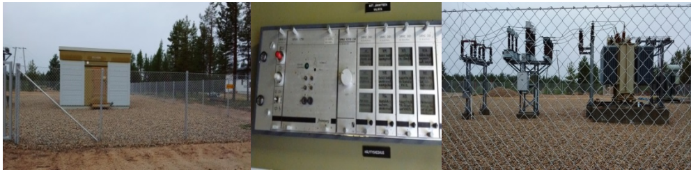
Kuva 1. Sähköasema, hälytysjärjestelmä ja ulkokenttä ovat osa tarkastettavia kohteita.
