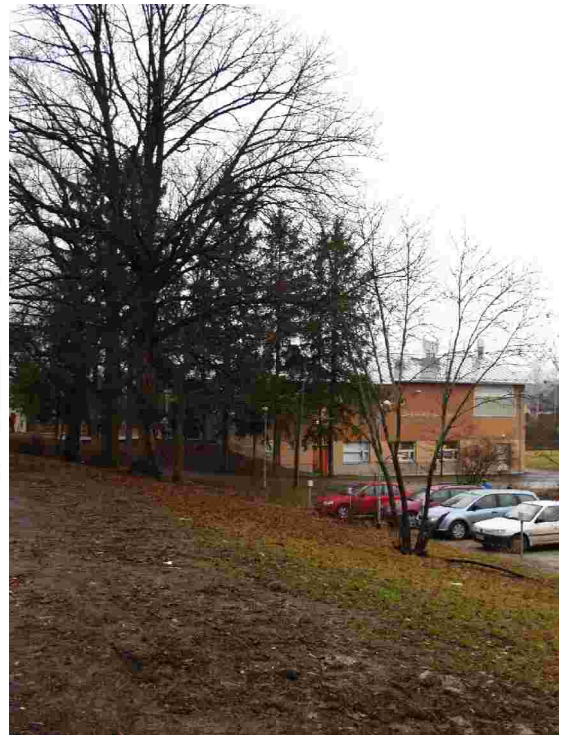
Kuva b. Vähä-Heikkilän koulun A - rakennuksen takaa
