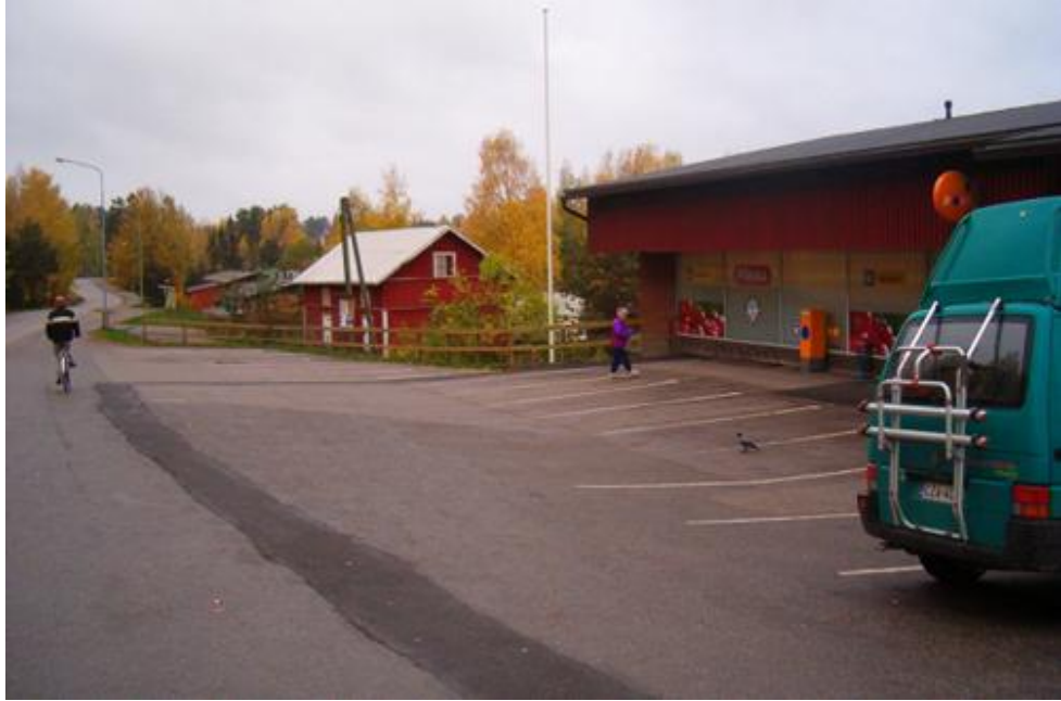
KUVIO 36. Liikerakennuksen pihalla kevyelle liikenteelle ei ole osoitettu selkeää kulkuväylää.
