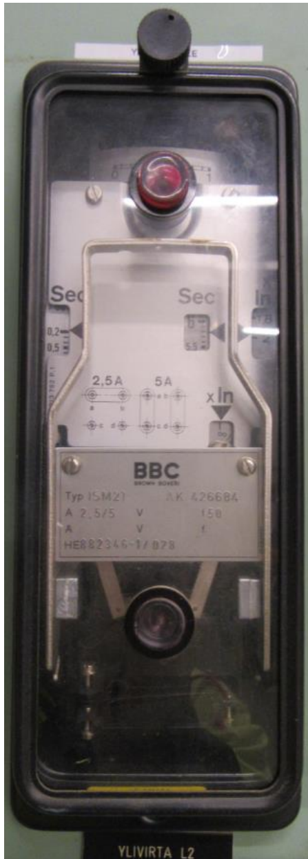
Kuva 1. Sähkömekaaninen ylivirtarele Brown Boverin valmistama ISM21
