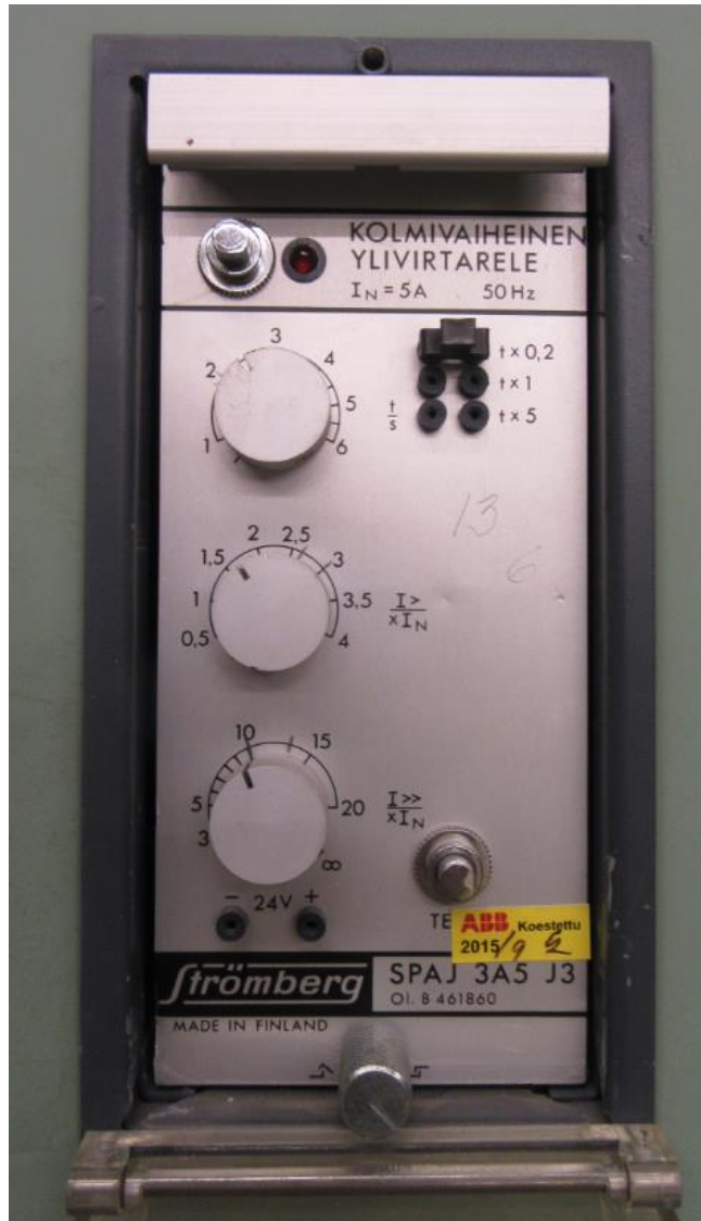
Kuva 2. Staattinen ylivirtasuojarele SPAJ 3A5 J3
