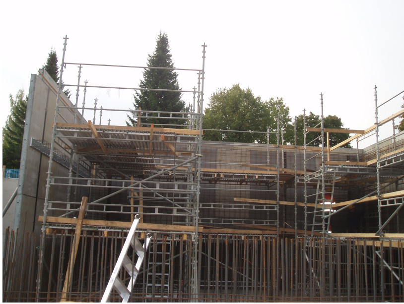
Kuva 3. Telineet raudoitustyölle
