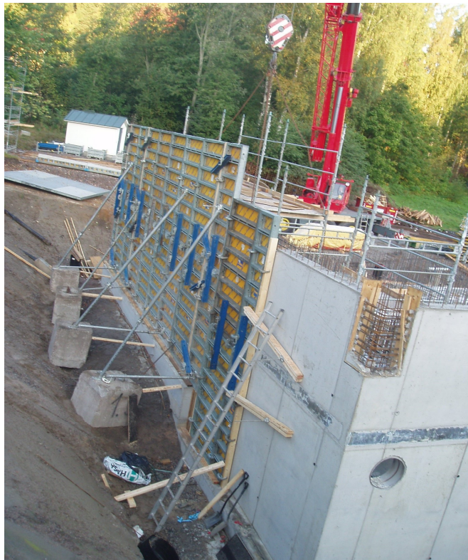
Kuva 2. Ulkopuolen muotti asennettuna
