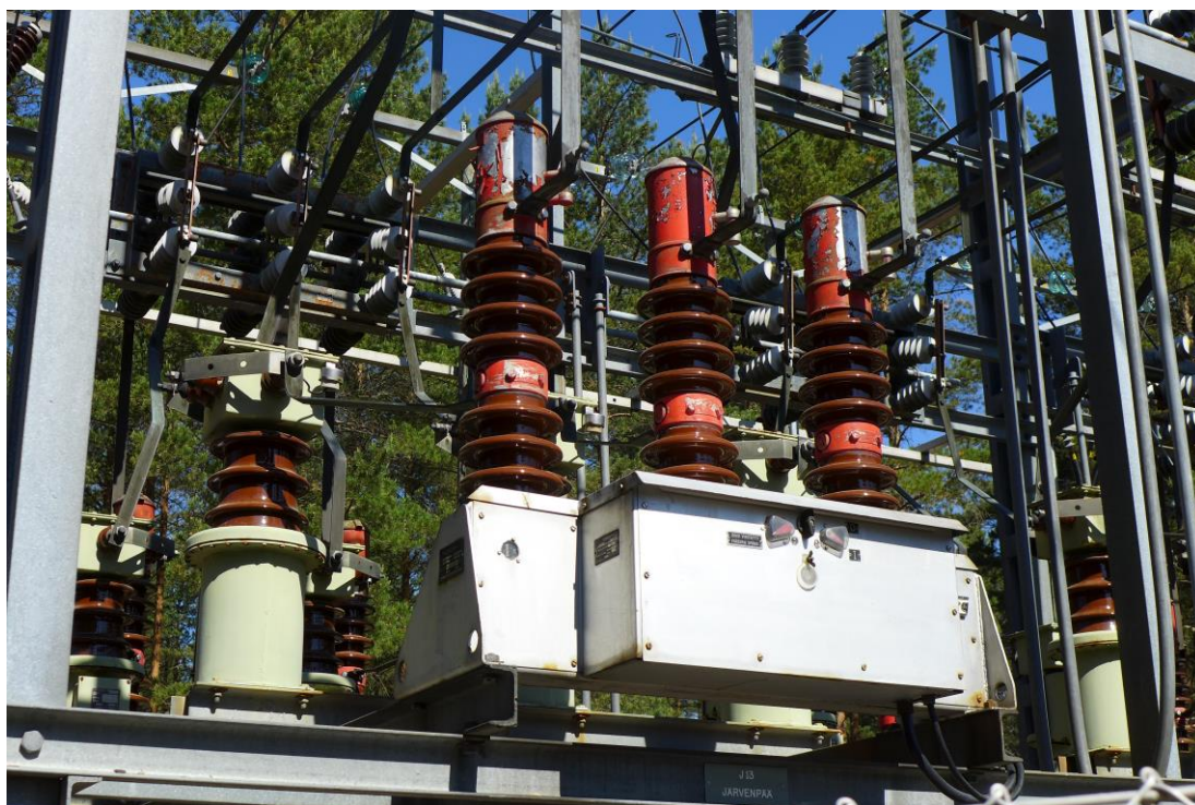
Kuva 8. Katkaisija Strömberg OSAR 24 T1
