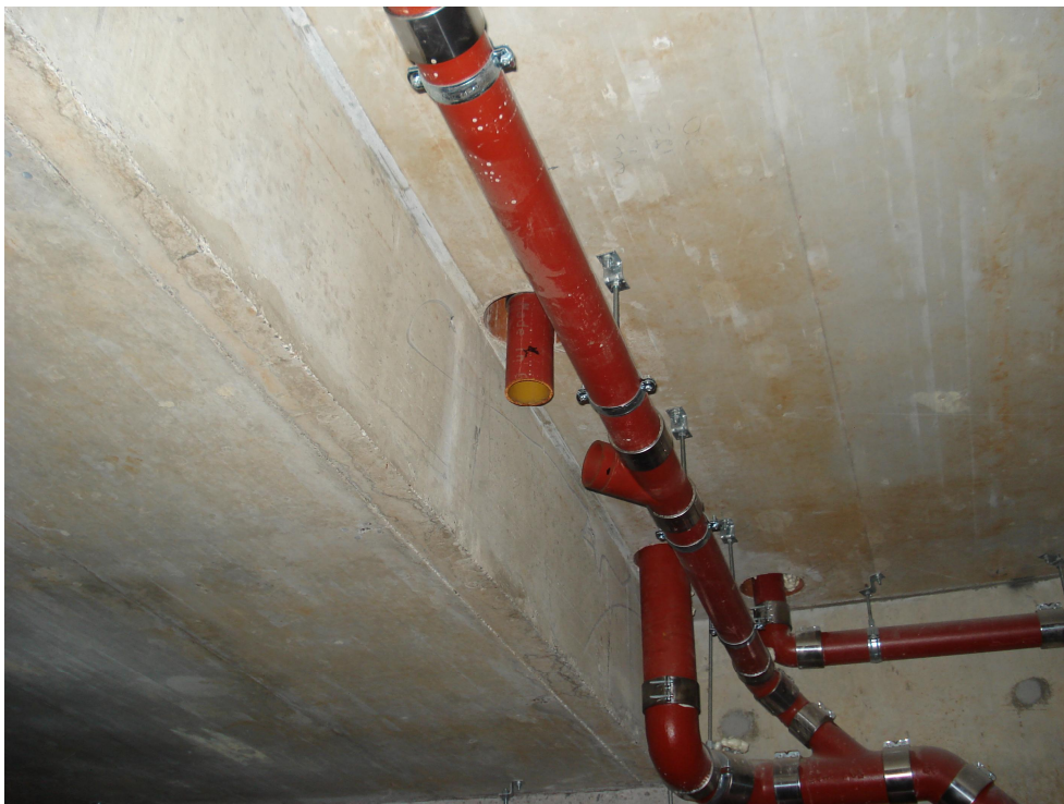
Kuva 5. Kytkemättömiä viemärinpäitä
