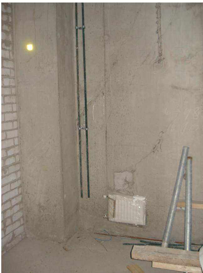
Kuva 11. Patterit asennettu ennen maalaamista
