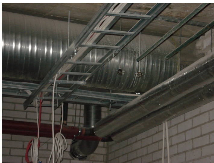
Kuva 10. Vanhoihin putkiin liittymine
