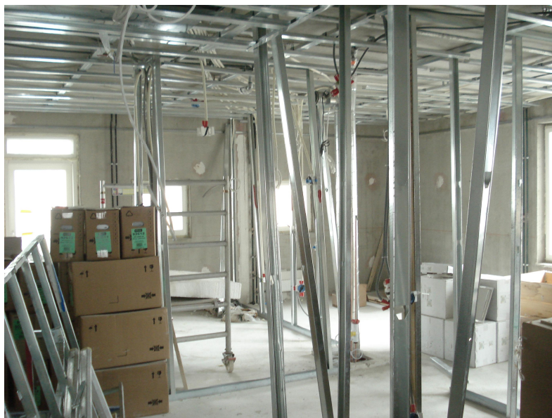
Kuva 6. Väliseinien valmiusaste
