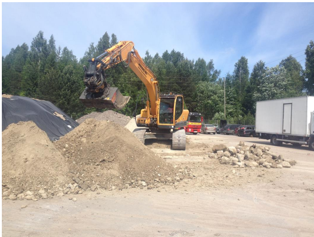
KUVA 1. Kivien erottelu kaivinkoneella
