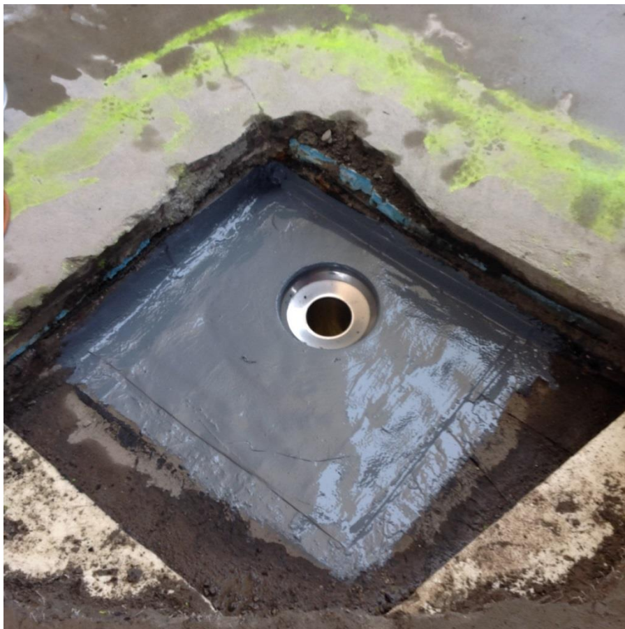
Kuva 13 Kaivon asennus vedeneristykseen Tiflex ProDetaililla. (Janne Laukkanen).
