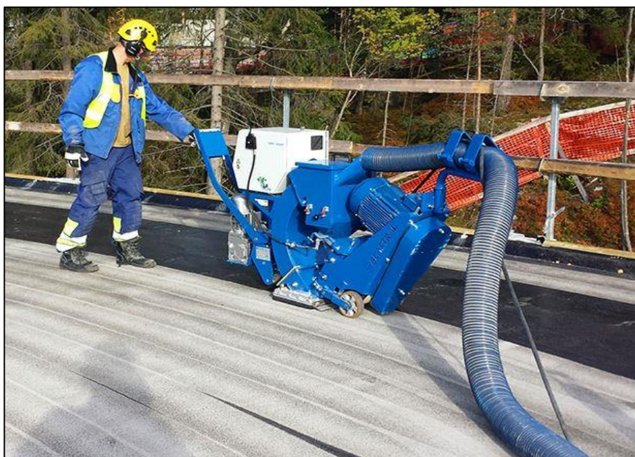
Kuva 6 sinkopuhallus käynnissä ( www.suomenteollisuusmyynti.fi ).
