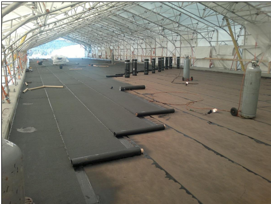
Kuva 8 Pintakermin asennusta asfaltoitavaan kanteen (Janne Laukkanen).
