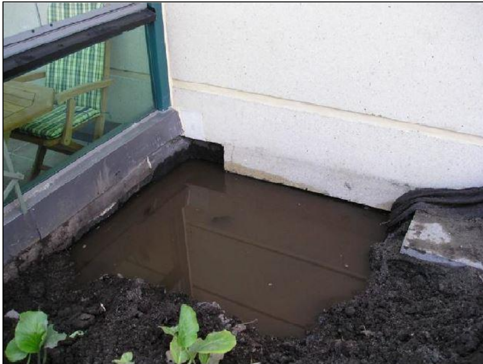
Kuva 2 Vesi on pahasti patoutunut ja lähellä ylösnoston rajapintaa (Janne Laukkanen ).
