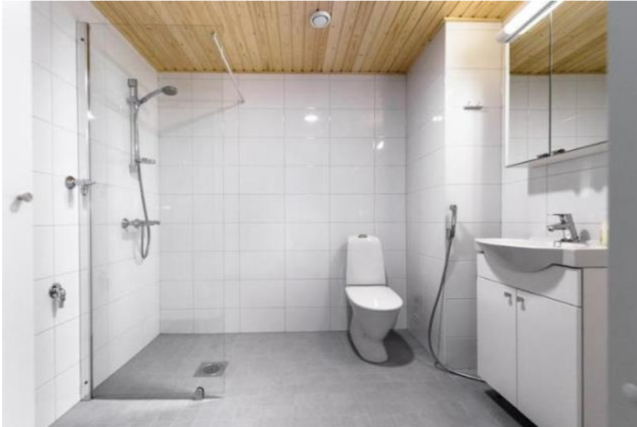
KUVA 6. Viitteellinen kuva kylpyhuoneen laatoituksesta. (7.)
