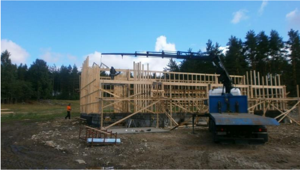
KUVA 3. Viitteellinen kuva ristikon nostosta. (5.)
