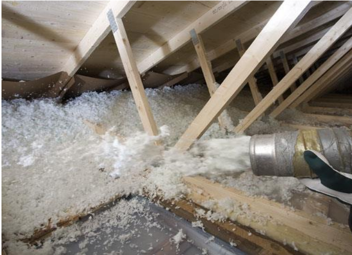
KUVA 4. Viitteellinen kuva yläpohjan puhallusvilloituksesta. (6.)
