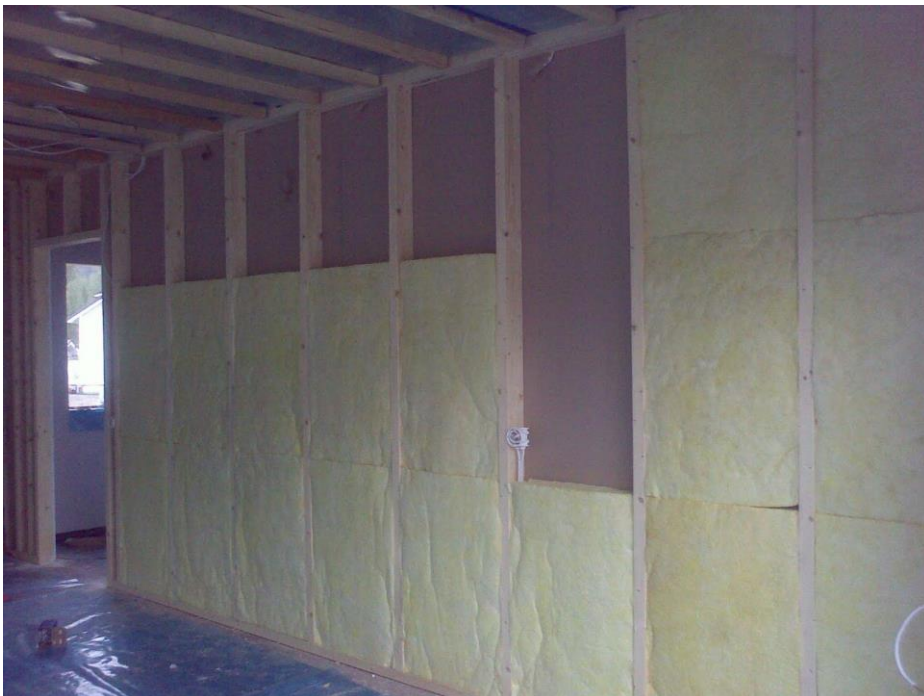
KUVA 5. Viitteellinen kuva väliseinätöistä. (7.)
