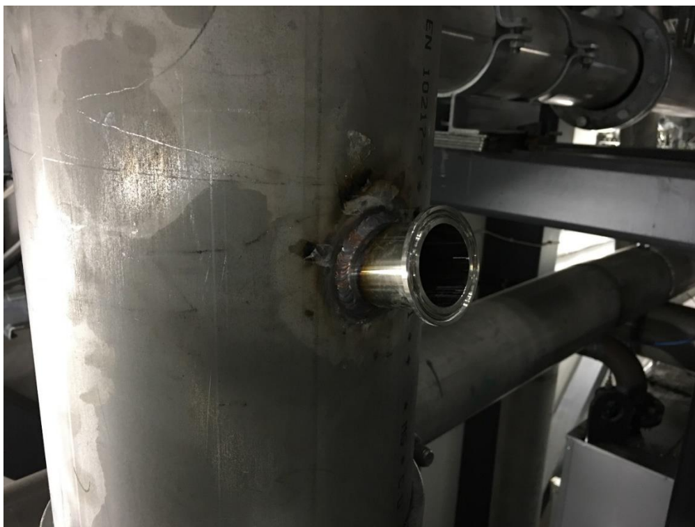
Kuva 10. SICK FW102:n Tri-Clamp-yhde hitsattuna savukaasukanavaan.
