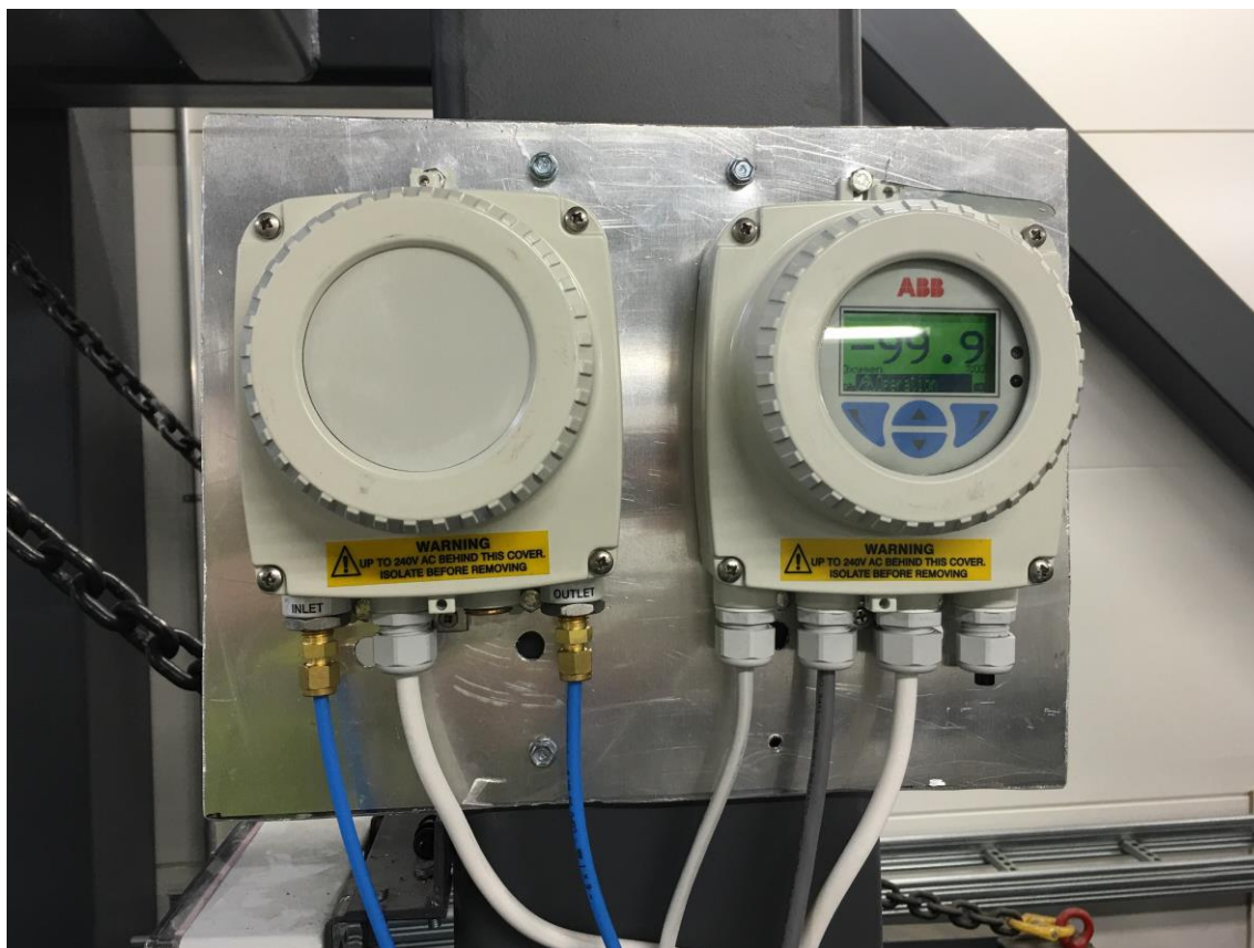
Kuva 14. ABB AZ25 -happimittarin oheislaitteet: referenssi-ilmapumppu ja lähetin.
