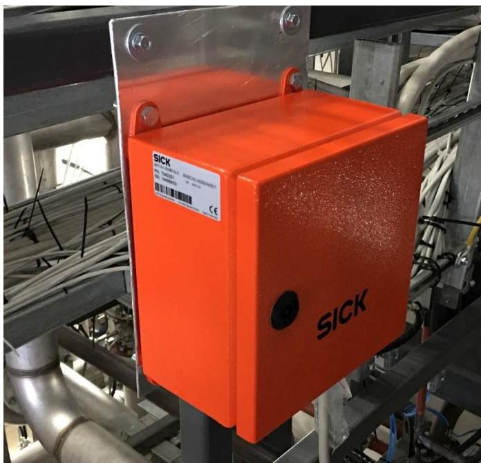
Kuva 13. FW102:n kytkentälaatikko.
