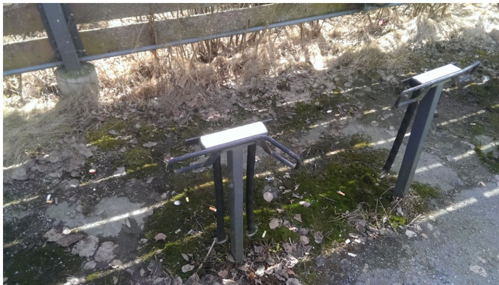
Kuva 21 Pahoin vaurioitunut tolppateline, joka ei ainakaan kannusta pysäköimään kyseiselle paikalle (Kuva Henri Luoto 2016).
