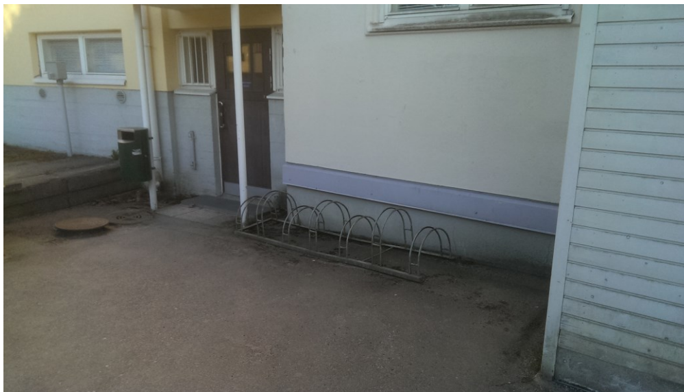
Kuva 44 Koulun takana sijaitsee yksi rengasteline, joka on tarkoitettu henkilökunnan käyttöön (Kuva Henri Luoto).
