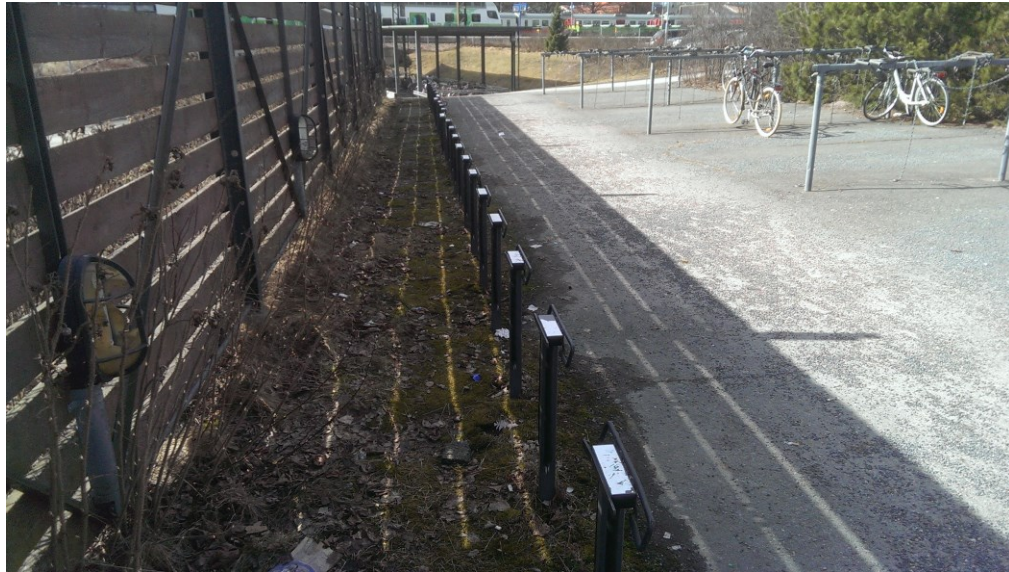
Kuva 19 Kunnossapidoltaan laiminlyöty pysäköintialue radan itäpuolelta (Kuva Henri Luoto 2016).
