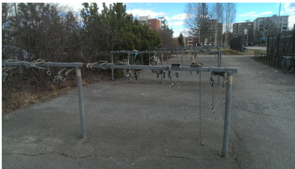
Kuva 18 Huonokuntoisia ohjaustankolukittavia telineitä radan itäpuolella (Kuva Henri Luoto 2016).
