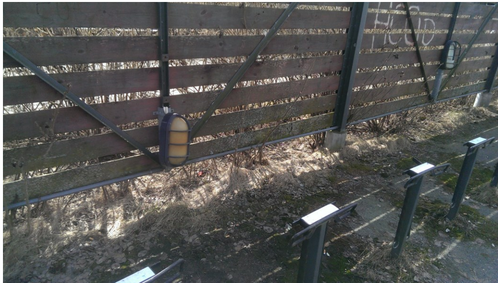
Kuva 20 Rikkinäisiä valaisimia ja kärsineitä tolppatelineitä radan itäpuolella (Kuva Henri Luoto 2016).
