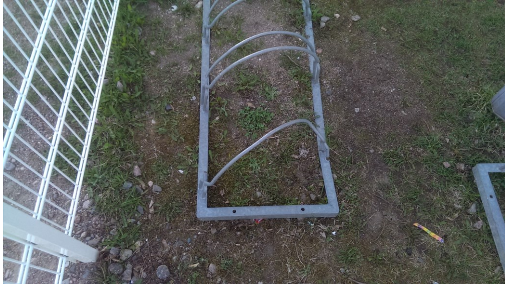
Kuva 42 Vaurioitunut pyöränpidike (Kuva Henri Luoto 2016).
