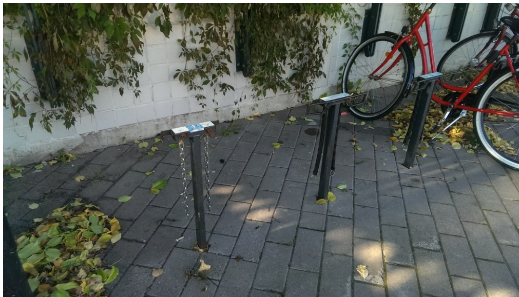
Kuva 53 Tolppateline ketjulukituksella on vähän tilaa vievä ja helppohoitoinen kunnossapidoltaan (Kuva Henri Luoto 2015).
