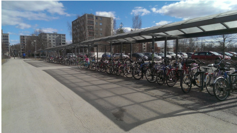
Kuva 16 Moderneilla tolppatelineillä ja katoksella varustettu pysäköintialue radan itäpuolella (Kuva Henri Luoto 2016).
