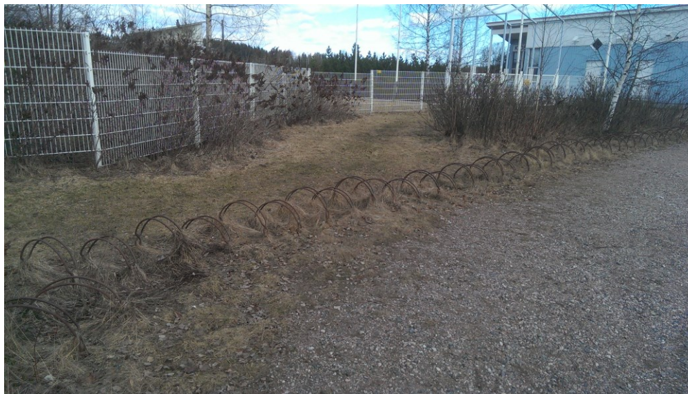
Kuva 29 Ruosteiset rengastelineet hukkuvat aluskasvillisuuteen ja ovat vaikeasti havaittavissa (Kuva Henri Luoto 2016).
