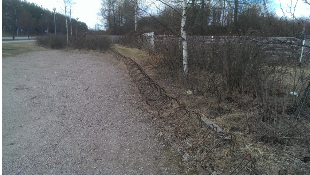
Kuva 27 Ruostuneita rengastelineitä Peltosaaren urheilukentän sisäänkäynnin luona (Kuva Henri Luoto 2016).
