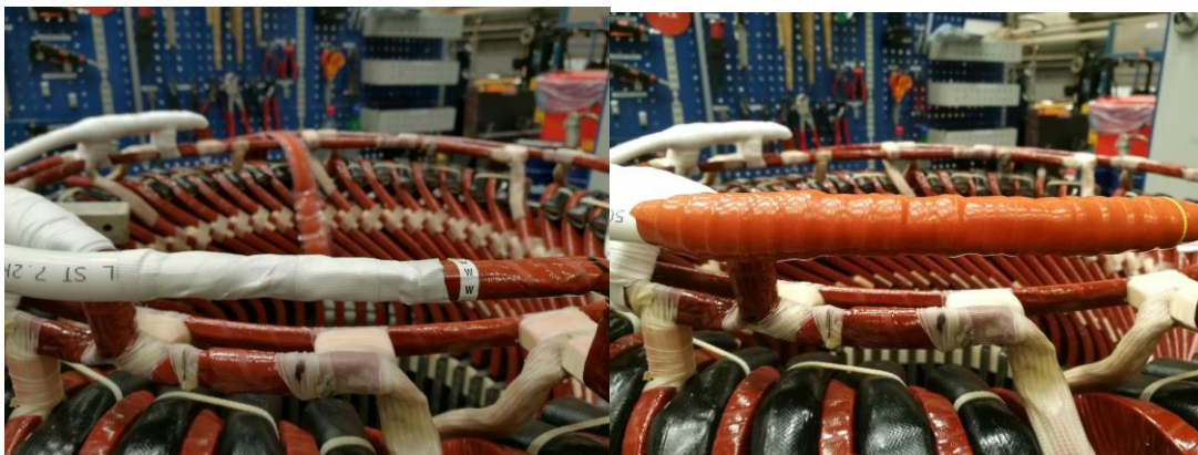
Kuva 5. Lasikuituteipillä ja silikonikuminauhalla eristetty liitäntä
