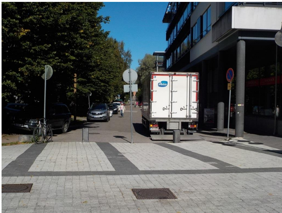
Kuva 33. Orvokkitien (pohjoispuoli Tikkuraitilta katsottaessa) ja Tikkuraitin liittymässä on kulkeesteet
