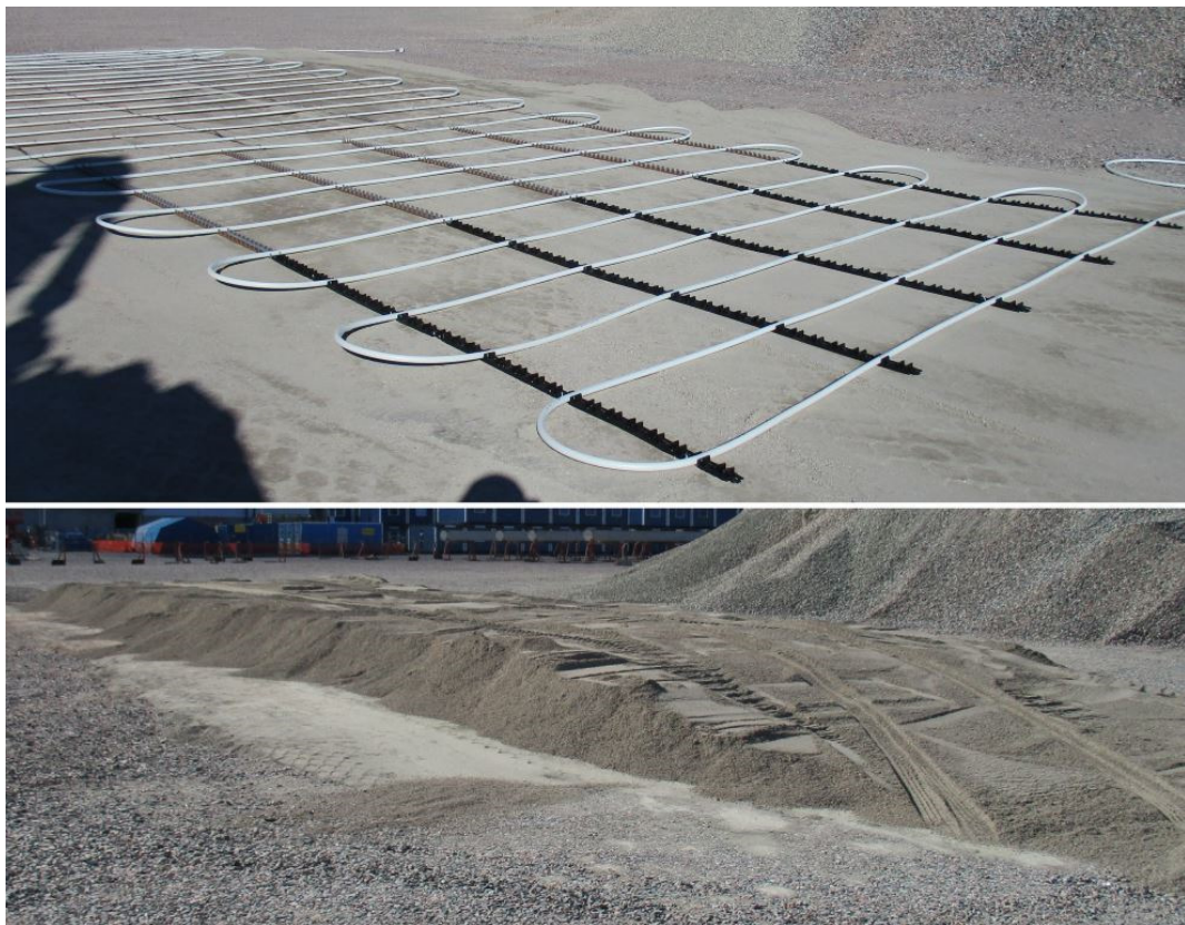
Kuva 27. Sulanapitoputkiston suojakerroksen koe. Suojakerrosta kuormitettiin ajamalla raskaalla kalustolla sen yli.
