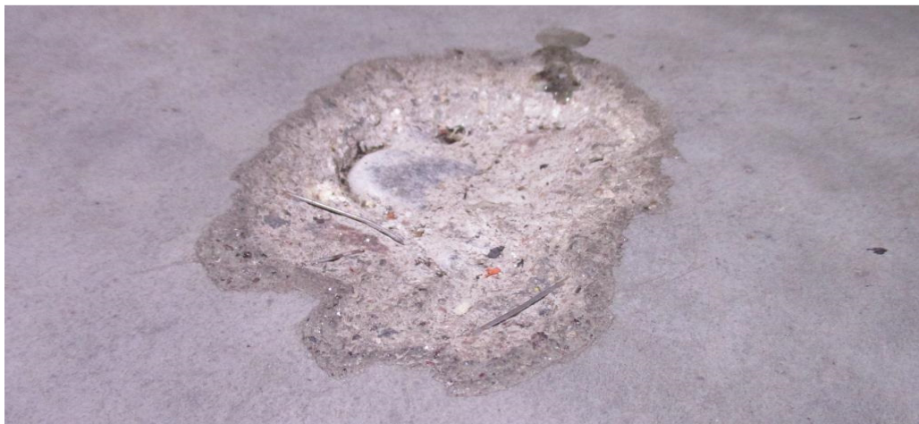
Kuva 52. Lattian pinta on pettänyt lähelle pintaa jääneen ison kiven takia.
