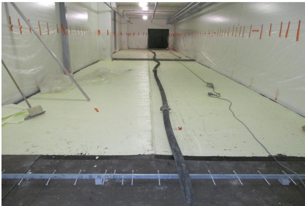
Kuva 48. Kulkukäytävässä päähän vedetty pumpun letku.
