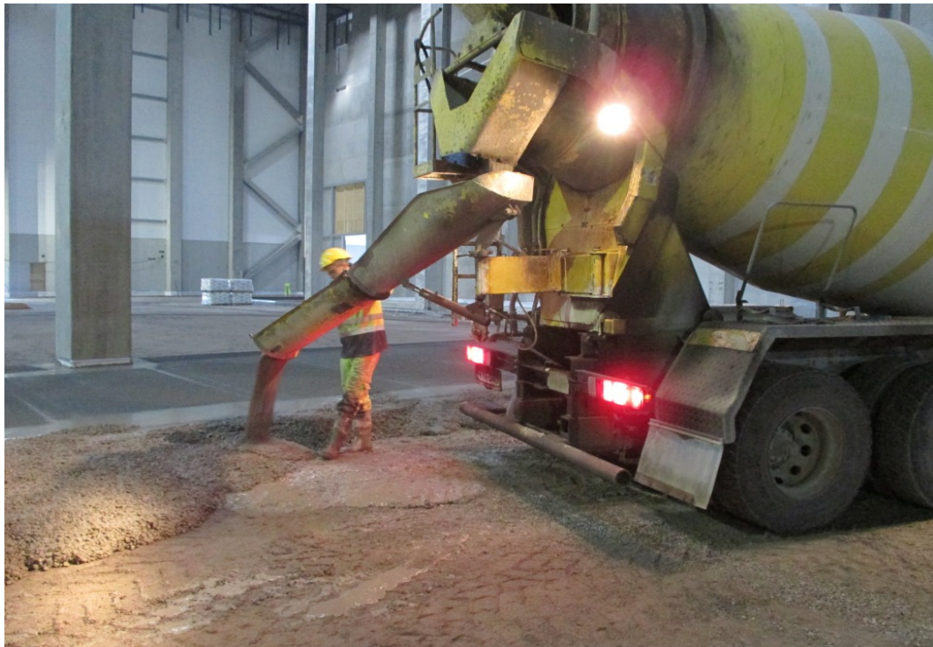
Kuva 11. Betonin levitys suoraan betoniautosta kourulla.
