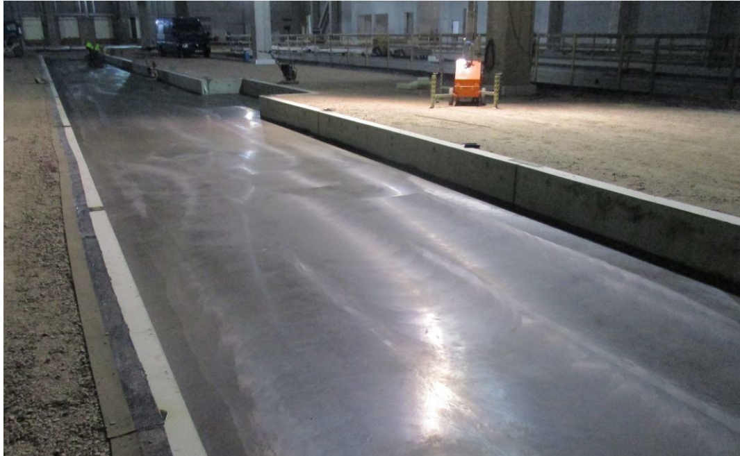
Kuva 18. Laitesyvennys, jonka pintalattia on juuri hierretty. Laitesyvennyksen ympäröivää lattiaa ei ole vielä valettu.
