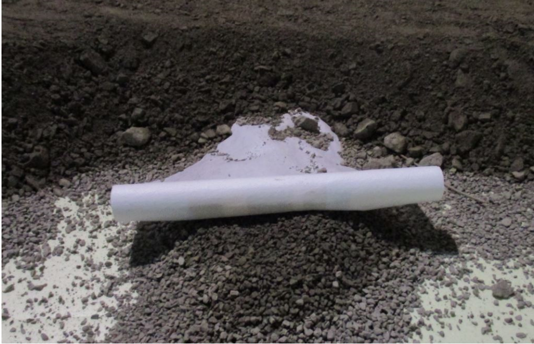
Kuva 39. Radoninpoisto on toteutettu suodatinkankaalla erotellulla sepeiväylällä.
