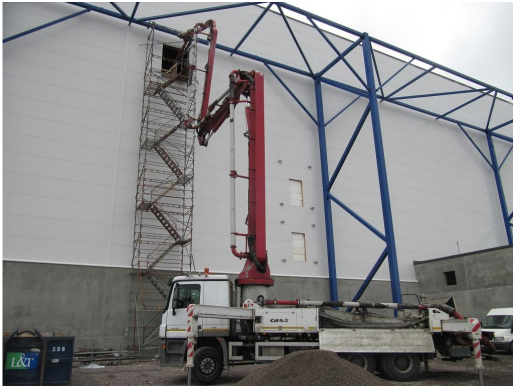
Kuva 20. Pumppuauto on jouduttu pystyttämään rakennuksen ulkopuolelle.
