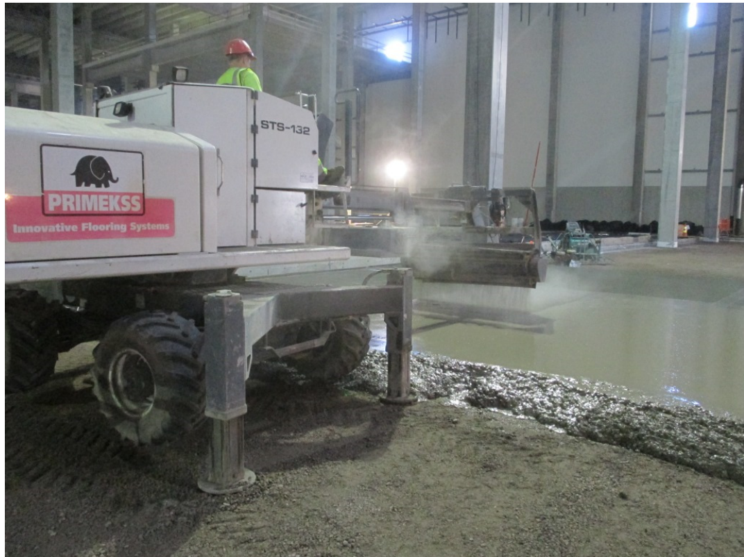
Kuva 13. Sirotetta levittävissä koneessa on myös pitkä puomi ja leveä palkki, jolla sirote leviää tasaisesti isolle alueelle kerrallaan.
