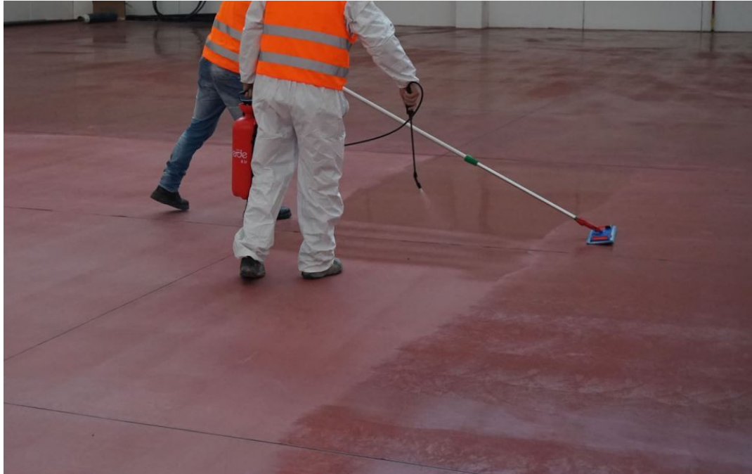
Kuva 15. Lattian pintakäsittely tehdään suihkuttamalla käsittelyainetta.
