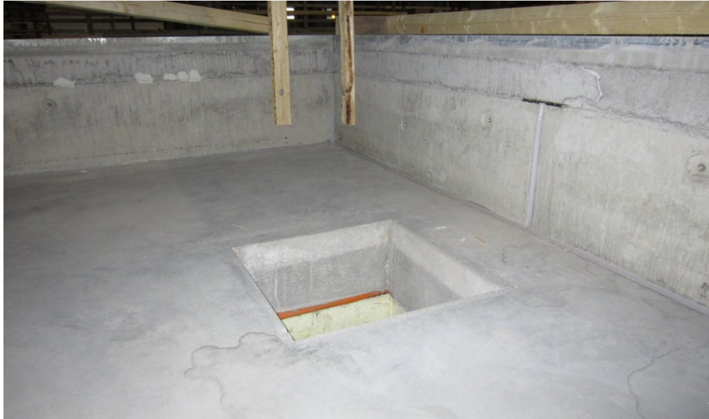
Kuva 19. Laitesyvennyksen pumppukaivo, kaivoa tulee suojaamaan vielä teräsritilä.
