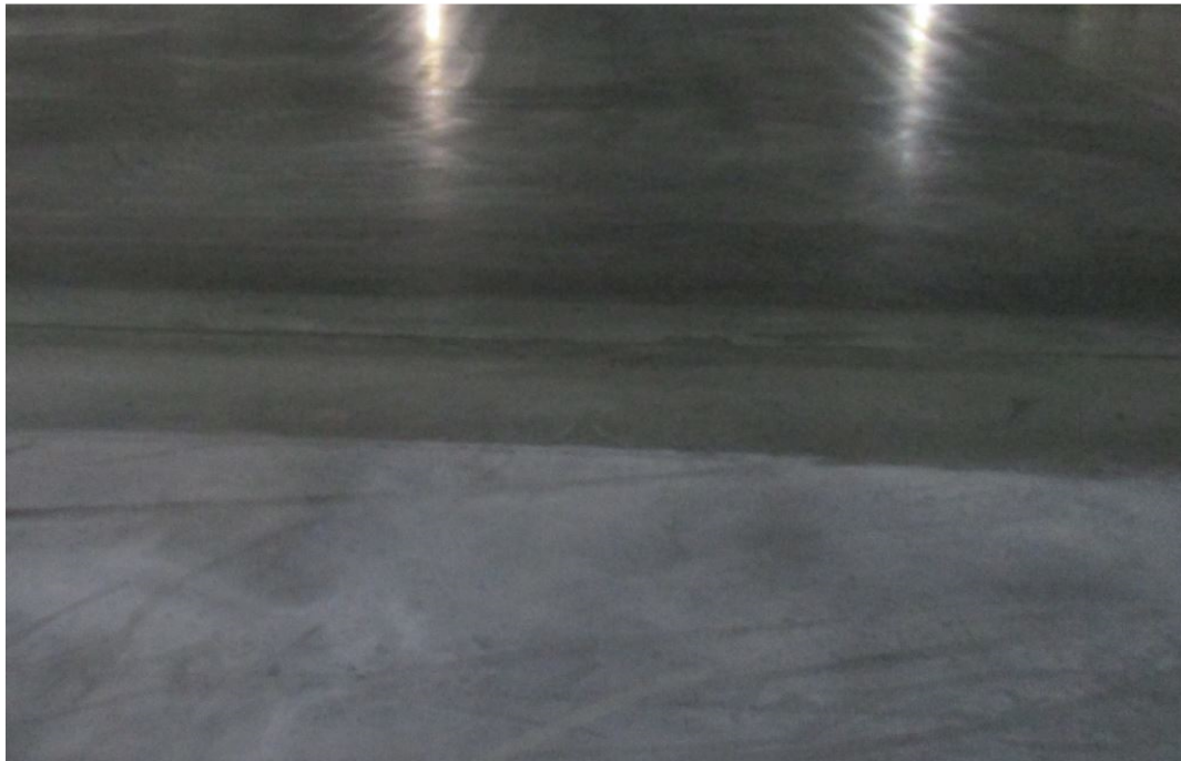
Kuva 46. Pentra-käsitelty lattia kiiltää ja on tummempi kuvan ylälaidassa. Käsittelemätön betonipinta on vaaleampi eikä kiillä kuvan alalaidassa.
