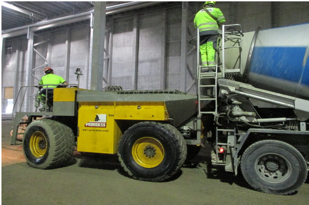
Kuva 10. Dumpperia täytetään betonilla betoniautosta.
