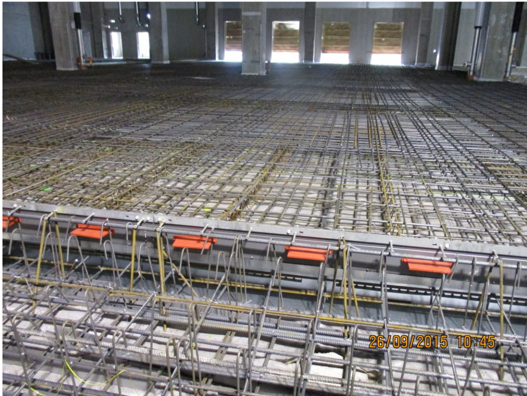
Kuva 23. Paalulattian raudoitus ennen valamista.
