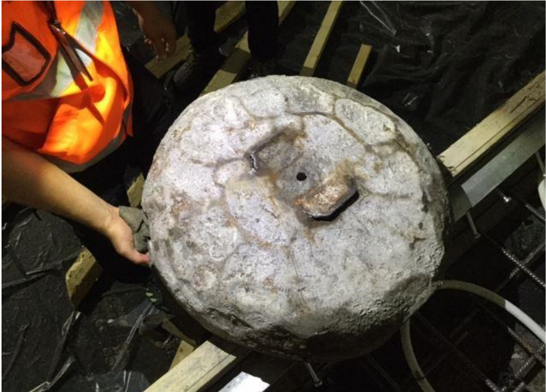
Kuva 54. Valuletkun liittimien suojana toimivan suojakuvun revennyt pohja.
