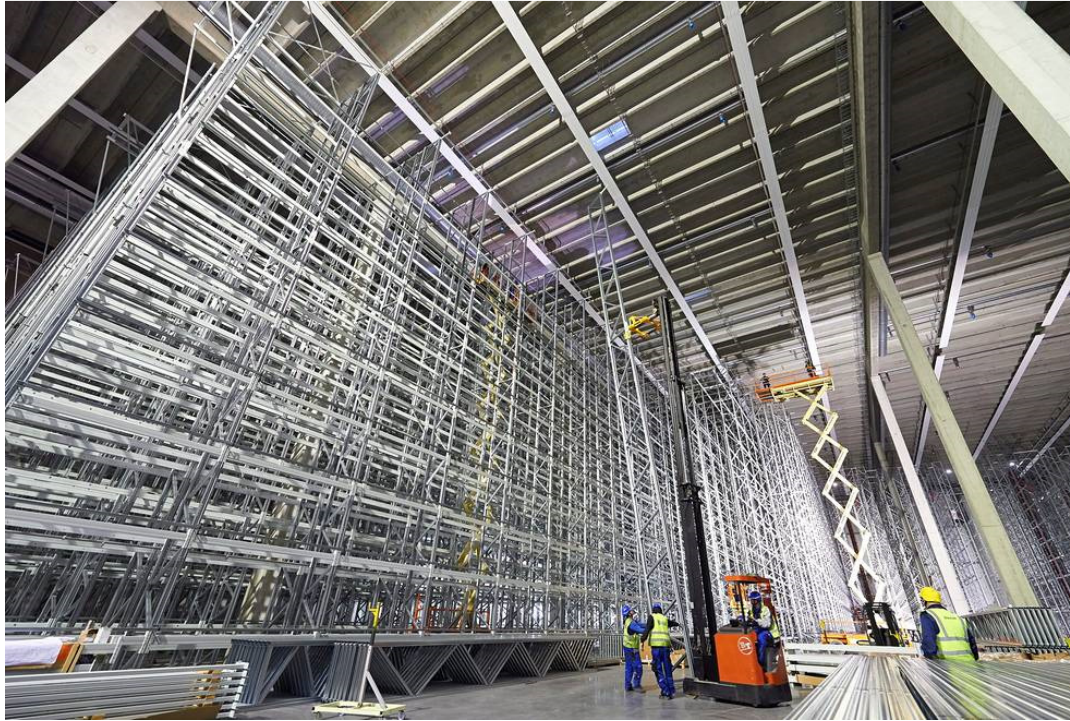
Kuva 3. Hyllyjärjestelmä toimitetaan suurina osina työmaalle, jossa ne kasataan yhtenäiseksi järjestelmäksi. [1.]
