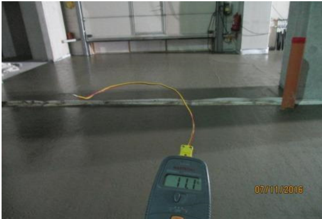
Kuva 61. Lämpötilan mittausta valettavassa tilassa.
