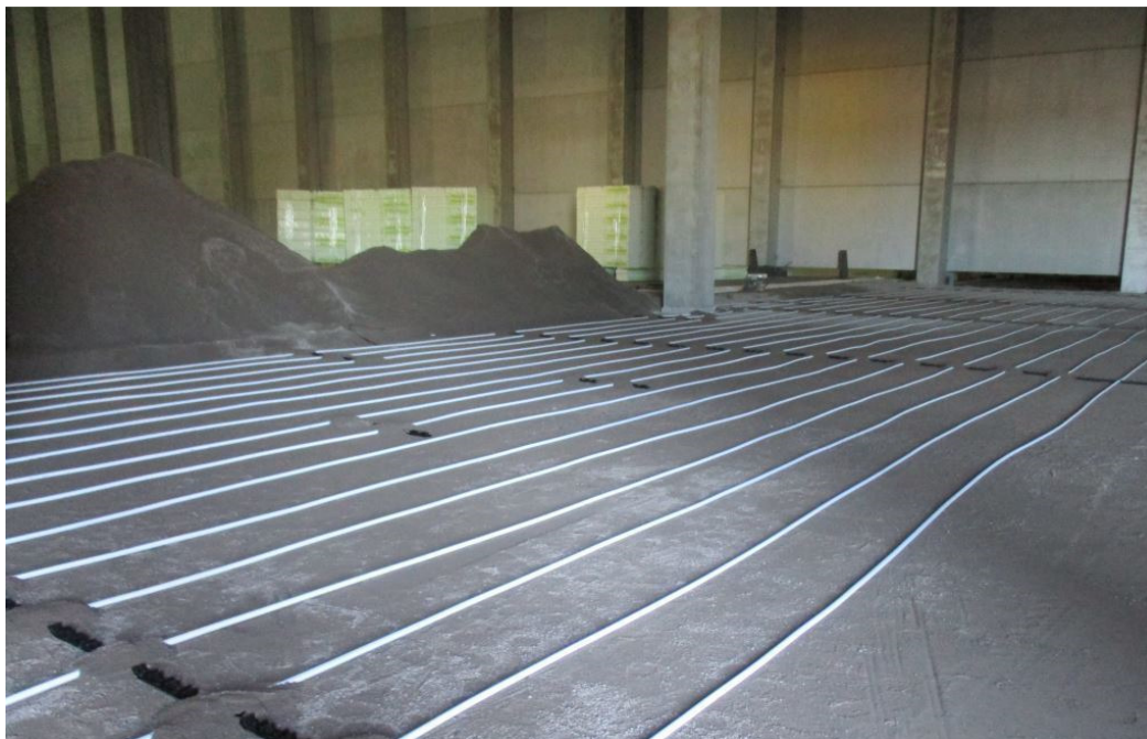
Kuva 35. Sulanapitoputkistoa levitettynä kentälle.
