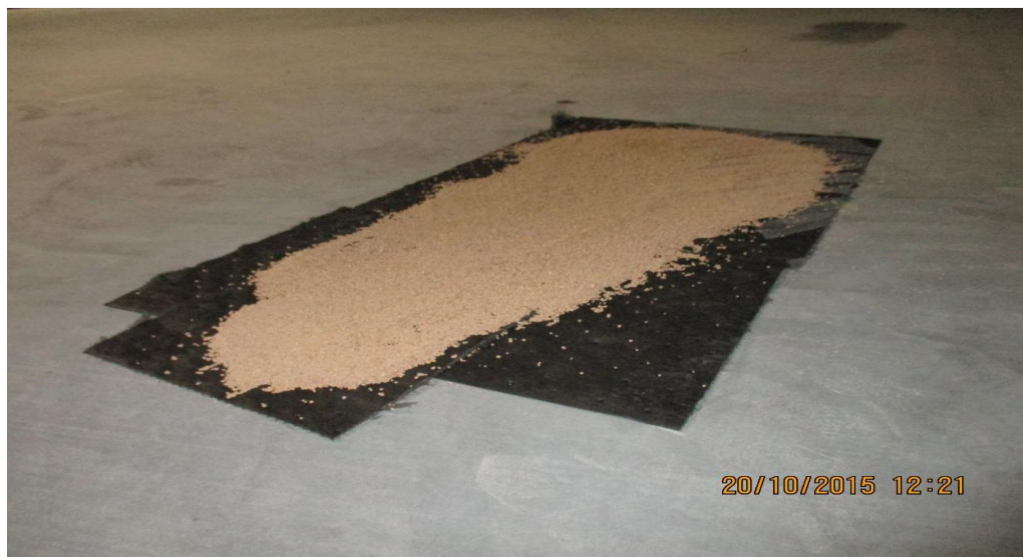
Kuva 59. Öljyvudon torjunta öljynimeytysaineella ja matoilla.
