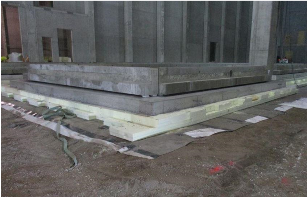
Kuva 40. Laitesyvennyksen L-elementit paikoilleen asetettuna.
