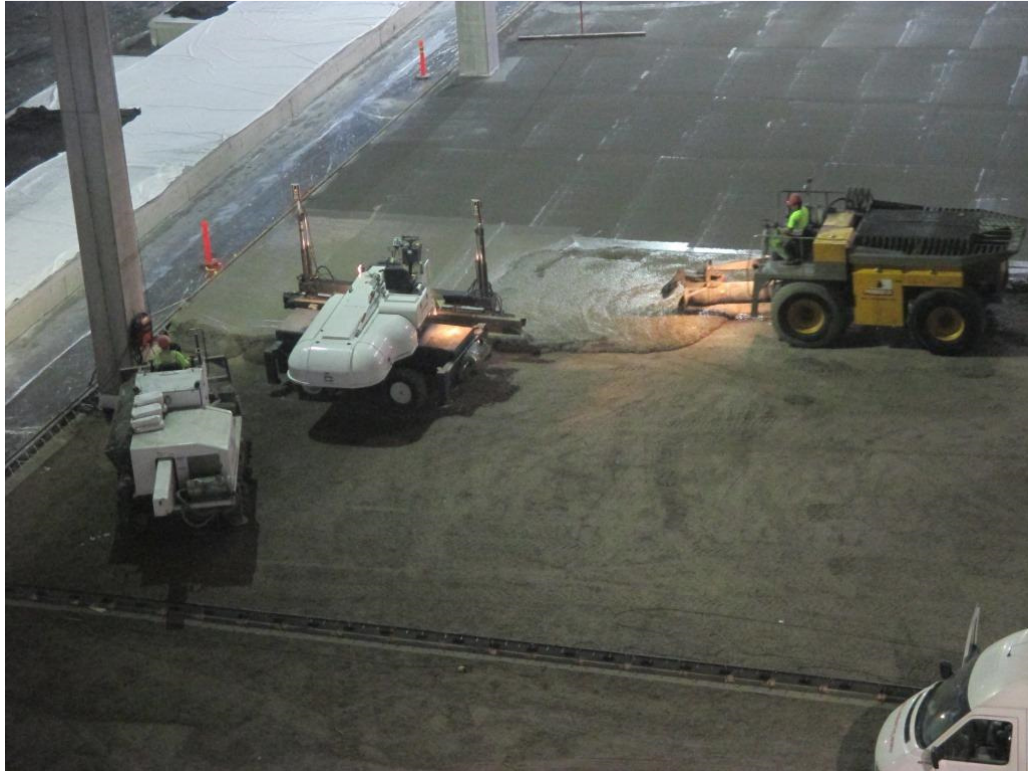
Kuva 67. Betonin levitys, tasaus, tärytys ja siroitepinnan levitys työvaiheet samassa kuvassa.
