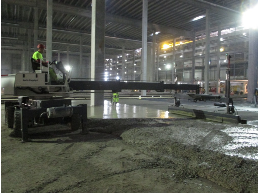
Kuva 12. Pitkällä puomilla ja leveällä palkilla saadaan nopeasti betoni tärytettyä ja tasoitettua oikeaan korkoon.
