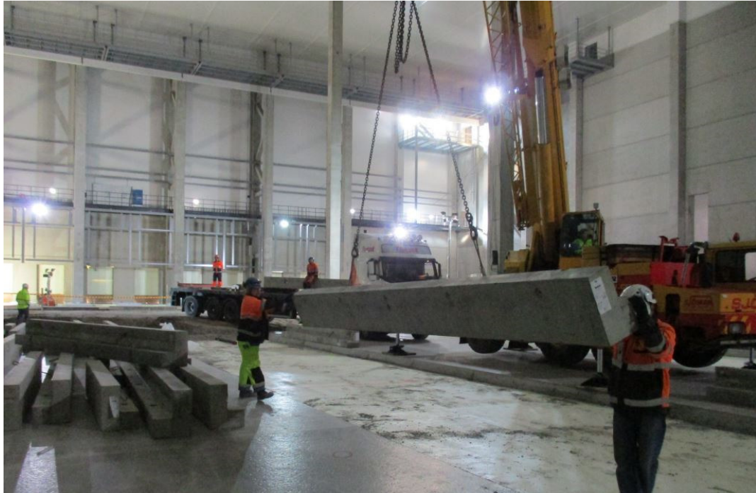
Kuva 38. L-elementtien haalausta ajoneuvonosturilla viereisen pohjalaatan päältä.
