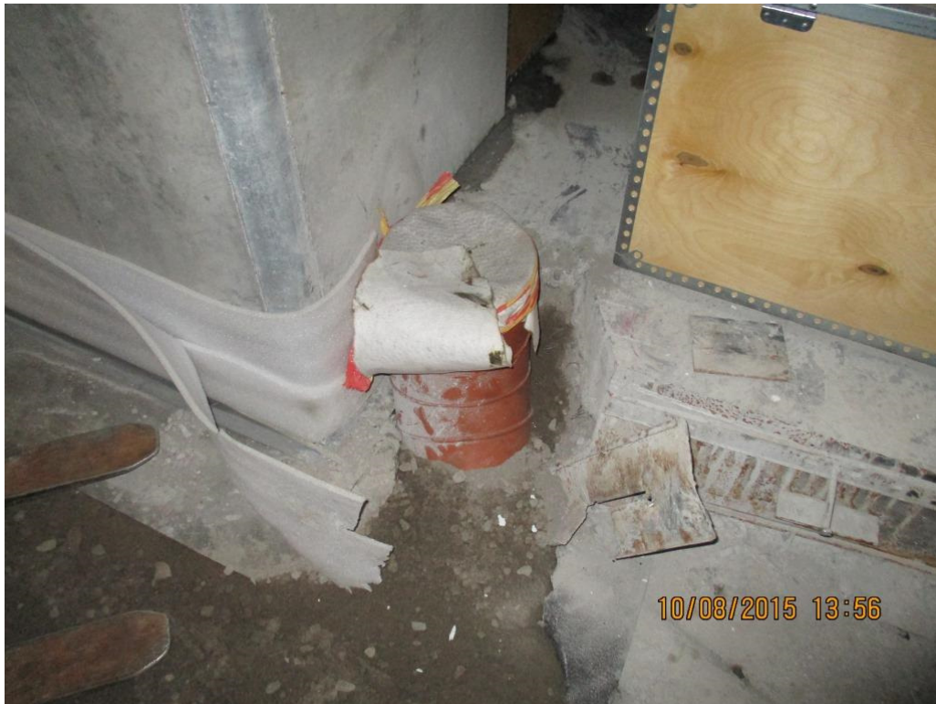
Kuva 57. Valmiiseen lattiaan sahattiin aukko, josta siirretty putken läpimeno tuotiin lattian läpi.
