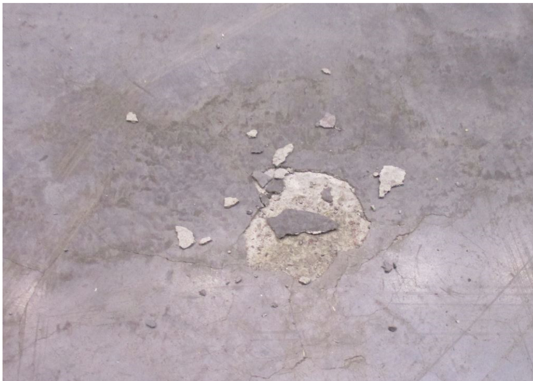
Kuva 17. Irronnutta sirotepintaa.
