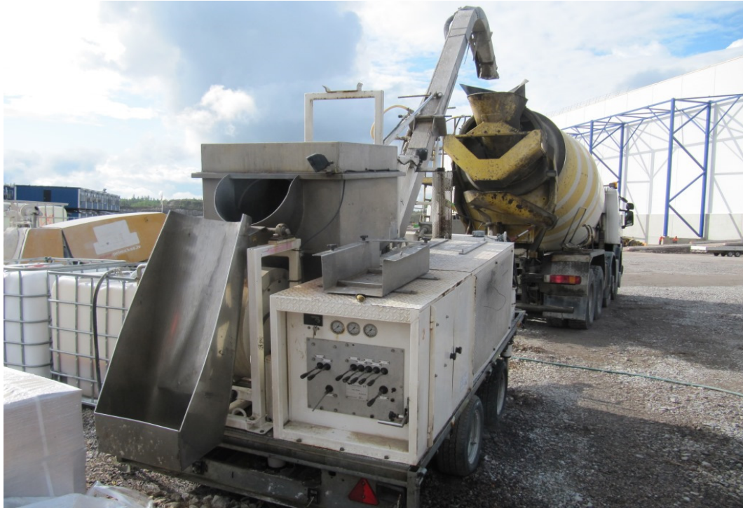
Kuva 6. Kone, jolla kuidut lisätään betonin sekaan. Teräsastia laskee kuidujen kilo-määrän ja putki puhaltaa kuidut auton säiliöön.
