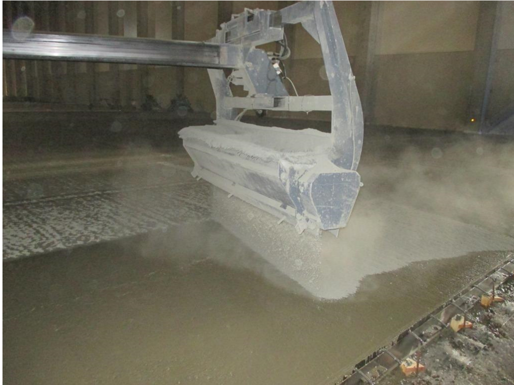
Kuva 66. Palkki levittää ja jakaa sirotteen tasaisesti betonilaatan päälle.
