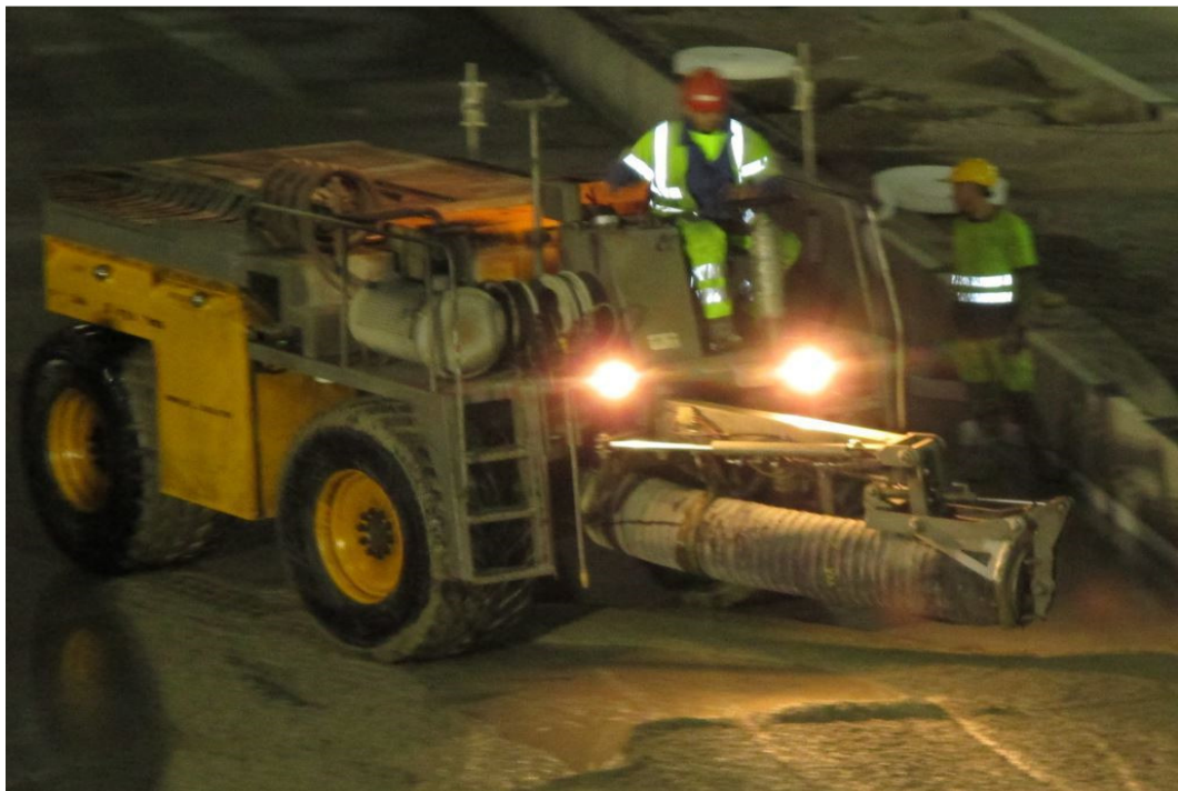
Kuva 7. Dumpperi levittää takana kyydissä olevaa betonia kärsää muistuttavalla suuttimella koneen keulasta.
