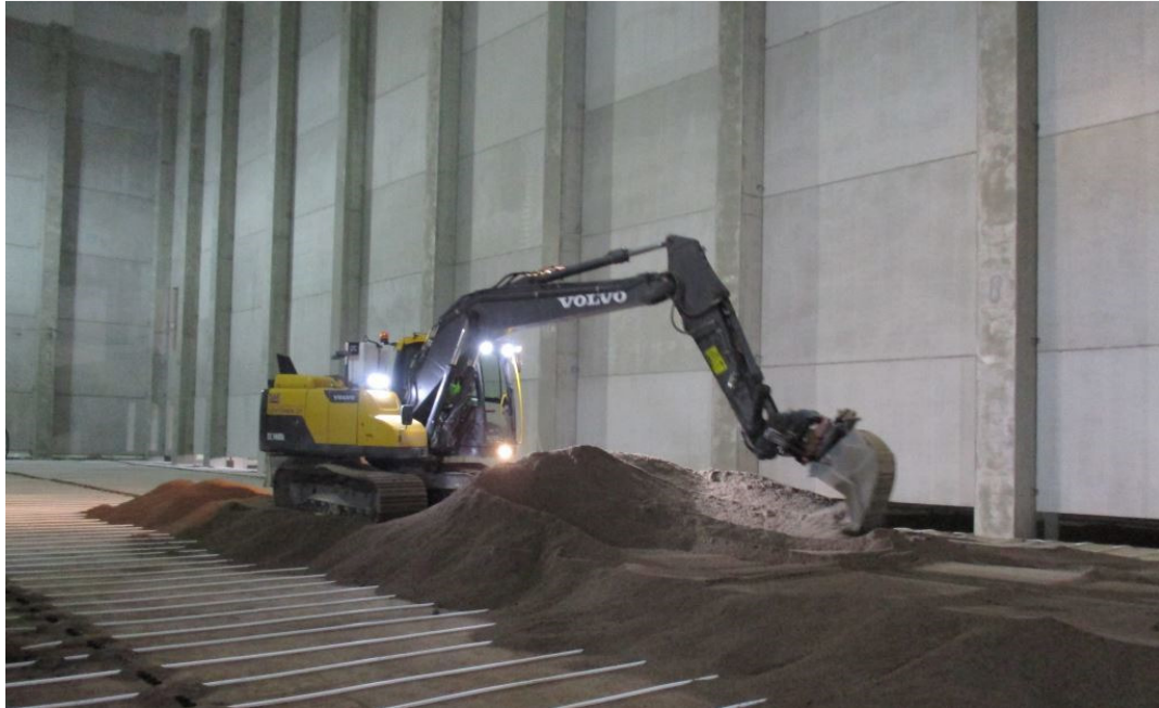
Kuva 36. Kaivinkone tekee suojakerroksesta tietä hallin päätyyn, mistä alkaa pohjamaan täyttö.
