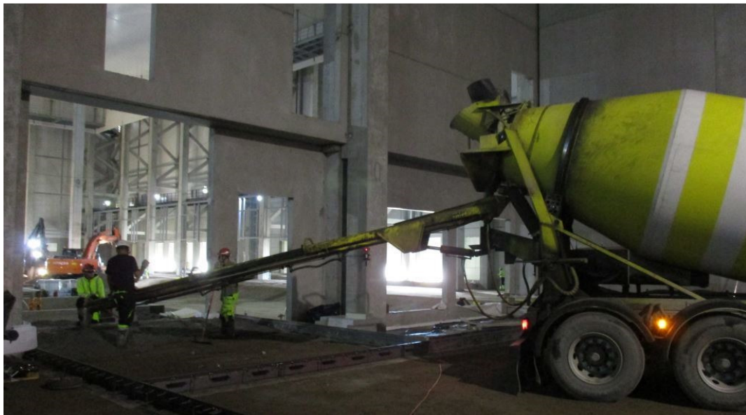
Kuva 44. Betonin levitystä betoniauton pitkällä kourulla.
