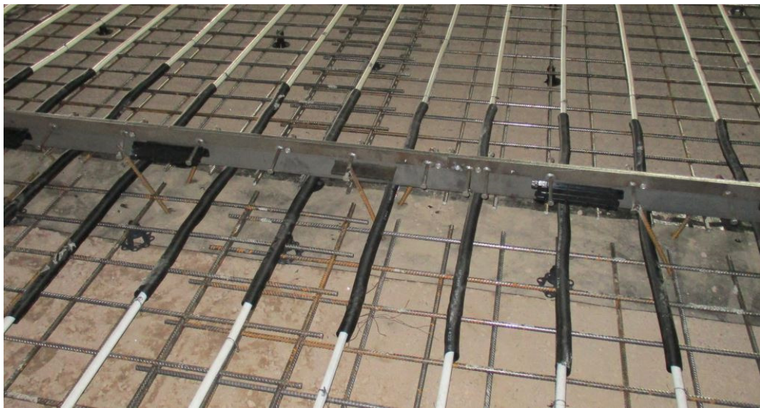
Kuva 41. Liikuntasauva asennettuna lattialämmitylle lattialle.
