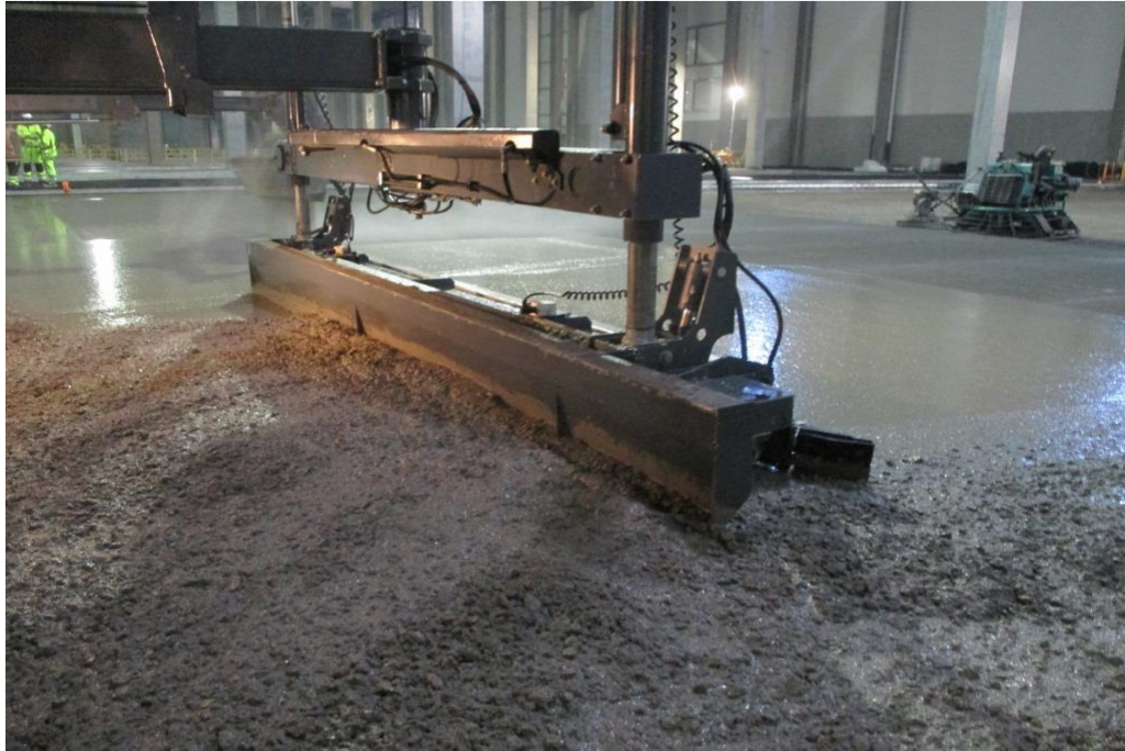
Kuva 65. Palkki täryttää ja tasaa betonin pinnan oikeaan korkoon.
