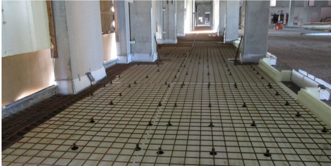
Kuva 29. Tuulikaapin lattiaeristys ja raudoitusverkko lattialämmitystä varten.
