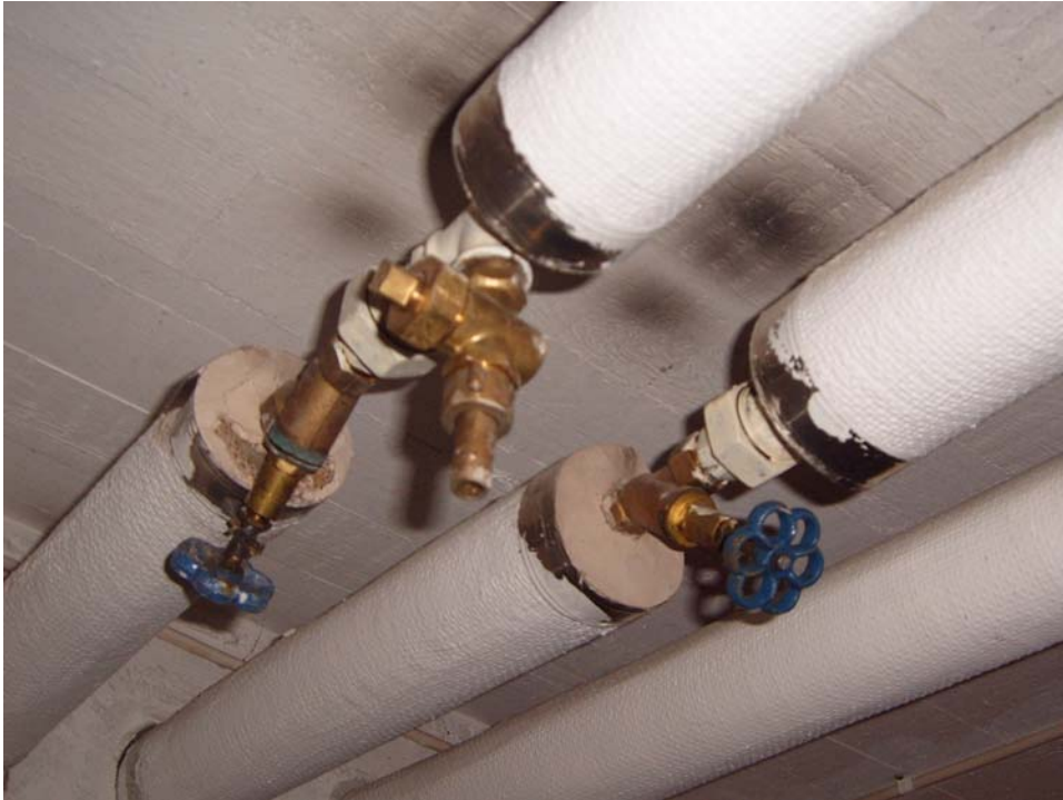
Kuva 21. Asbestia sisältävät lämmitysverkoston suojaeristeet poistetaan.
