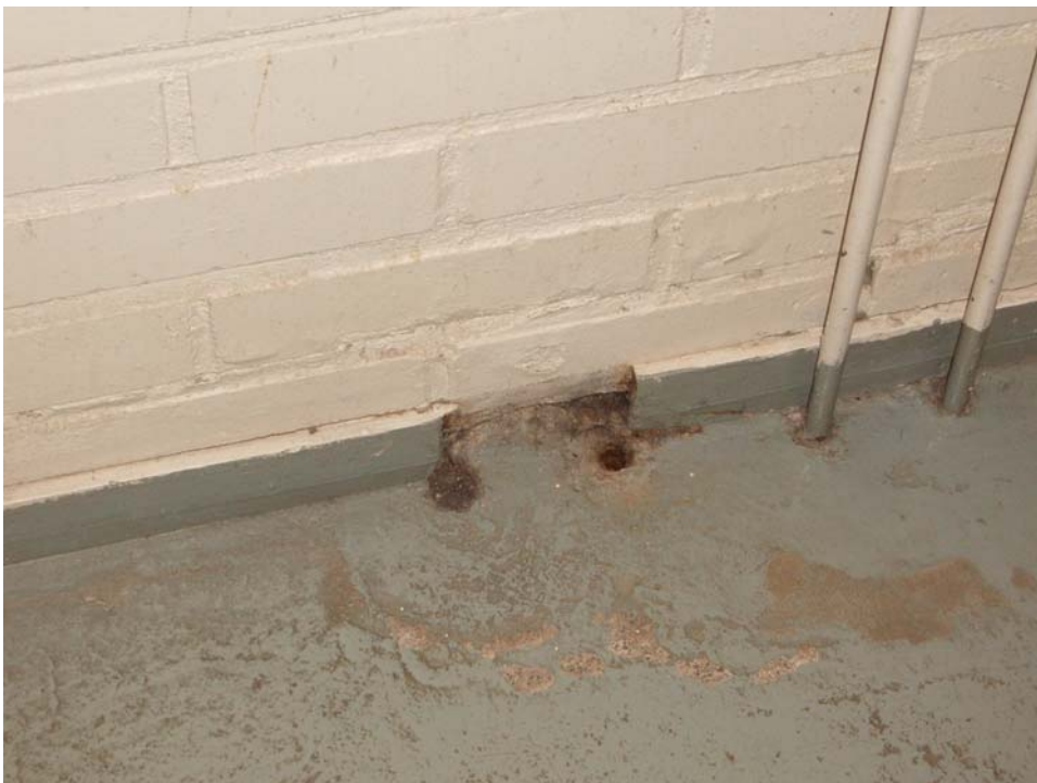
Kuva 18. Kaikki yleistilojen seinä-, katto- ja lattiapinnat kunnostetaan sekä maalataan.
