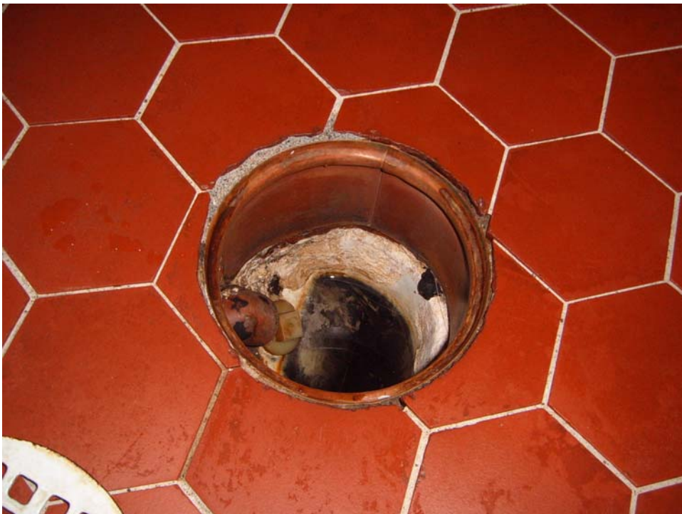
Kuva 16. Saunaosasto peruskorjataan ja seiniin sekä lattioihin lisätään vedeneristys.
