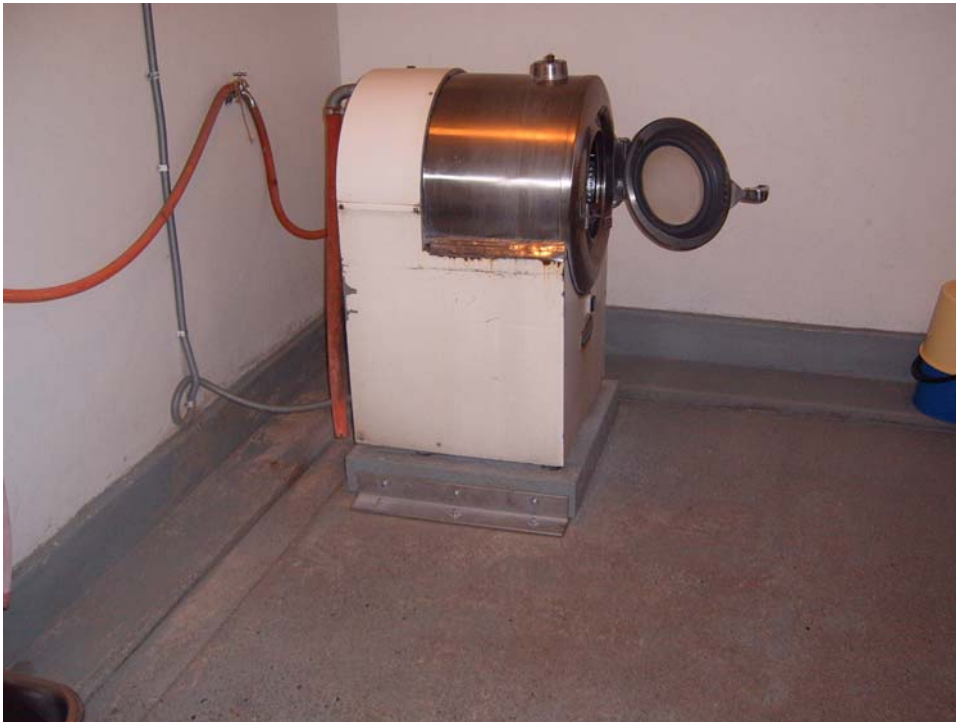
Kuva 17. Pesutupa kunnostetaan mahdollisen saunaosaston peruskorjauksen yhteydessä.
