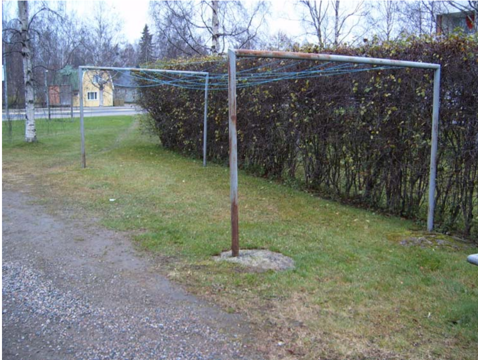
Kuva 3. Ruostuneet talovarusteet (D82) puhdistetaan pintaruosteesta esim. hiekkapuhaltamalla ja pintakäsitellään asianmukaisella tavalla.
