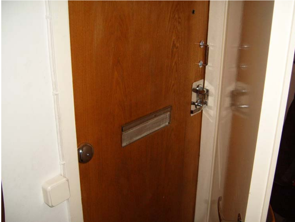
Kuva 19. Huoneistojen pääovet vaihdetaan uusiin äänieristettyihin oviin.
