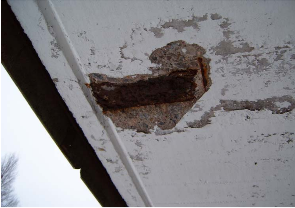
Kuva 9. Parvekkeille (F34.1) suoritetaan parvekkeiden kuntotutkimus sekä niille asianmukaiset korjaustyöt.
