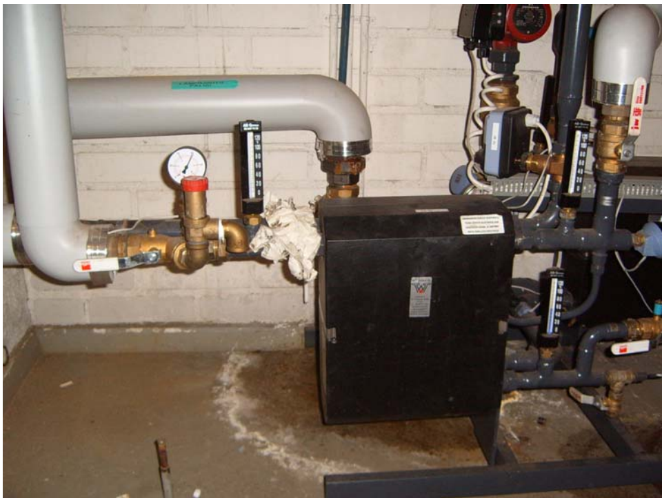
Kuva 20. Lämmönjakolaitteen putkiliitoksen vuodon korjaus.
