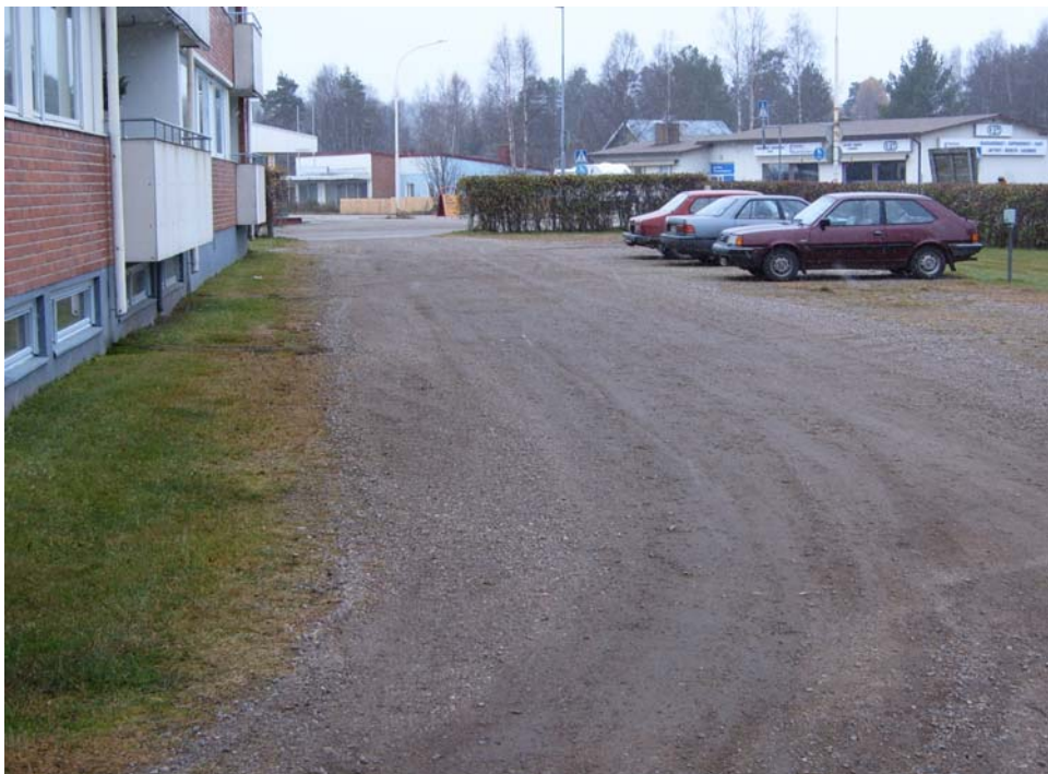
Kuva 2. Sorapäälysteisten (D72.1) piha- / liikennealueiden asfaltointi tai pintamaa-ainesten uusiminen.
