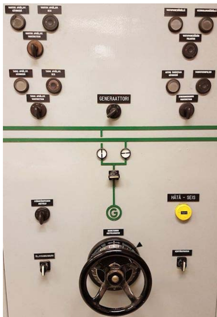
Kuva 23. Magnetoinnin ja tahdistuksen käyttötaulu.
