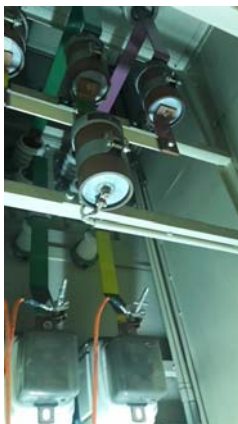
Kuva 26. Siemens-Schuckert -generaattorin tähtipiste tasolla +3,4 m.
