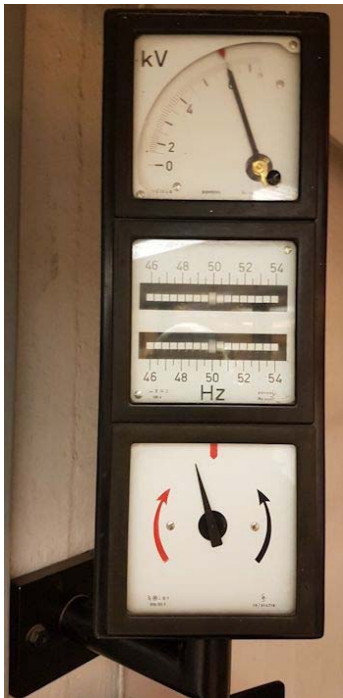
Kuva 24. Käytössä oleva tahdistuksen synkroskooppi ja taajuusmittaristo.
